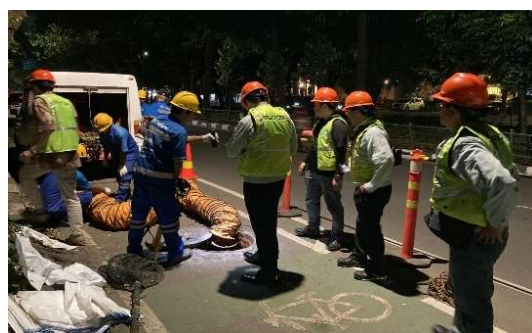
Zone-0 での下水道管渠清掃作業（機材利用）の視察 （ジャカルタ）
