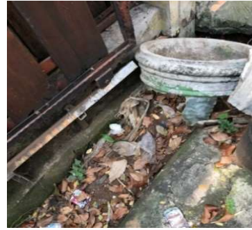
<ジャカルタ市内の側溝>
