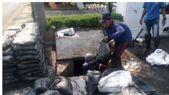
図 2-1：ジャカルタ市内での汚泥除去作業の様子
