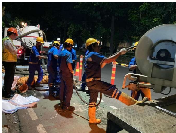
高圧洗浄作業風景
