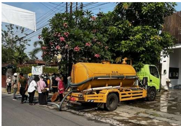
給水車を導入しての下水管内の汚泥吸引作業
