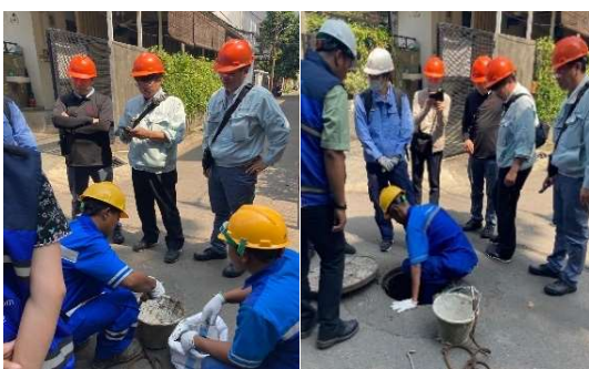
Zone-0 での下水道管渠清掃作業（手作業）の視察 （ジャカルタ）
