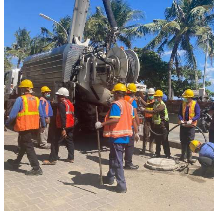
下水道内への高圧洗浄作業風景
