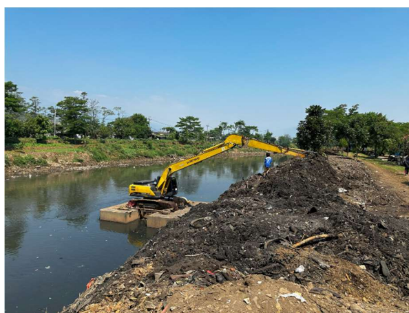
〈川のごみを回収し、川岸に埋める作業〉
