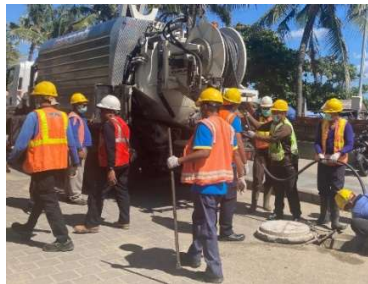
デンパサール市内の清掃作業
