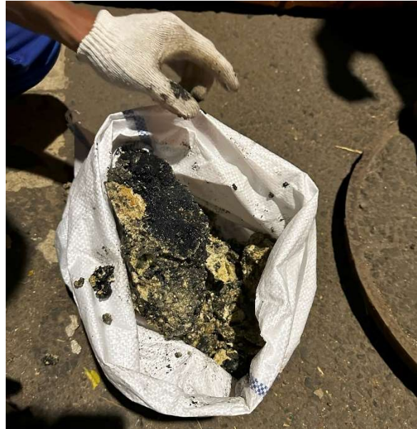
下水管内から回収された油脂・ゴミの塊
