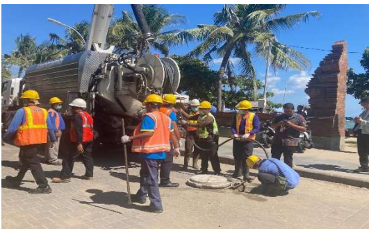
下水道管渠清掃作業（手作業）の視察 （デンパサール）
