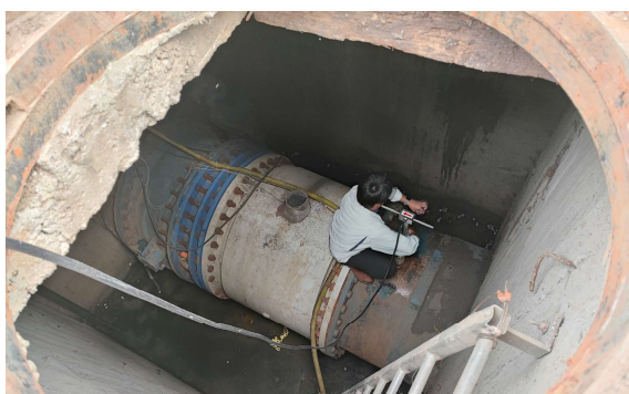
【写真 11】 DMA 内の提案製品の装着 (白い部分が既設の電磁流量計)
