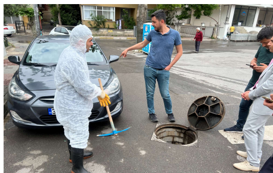
【写真 8】街中の DMA 内水道管の实地調査
