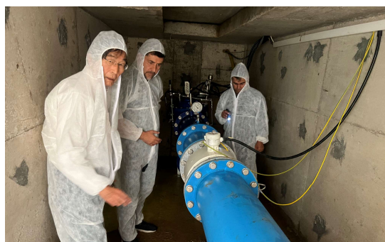
【写真 7】DMA 内水道管仕様の实地調査
