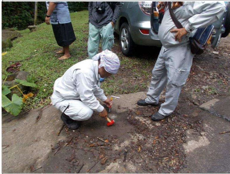
簡易基準点設置状況
