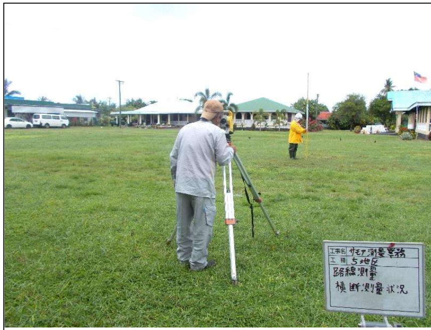
横断測量状況
