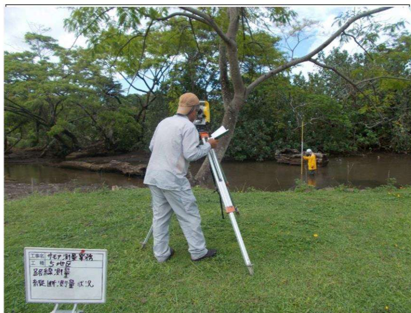
縦断測量状況
