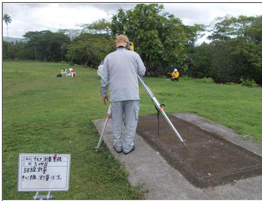
中心線測量状況
