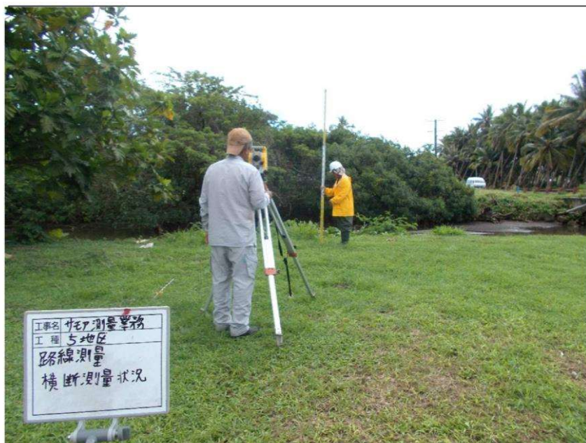
横断測量状況
