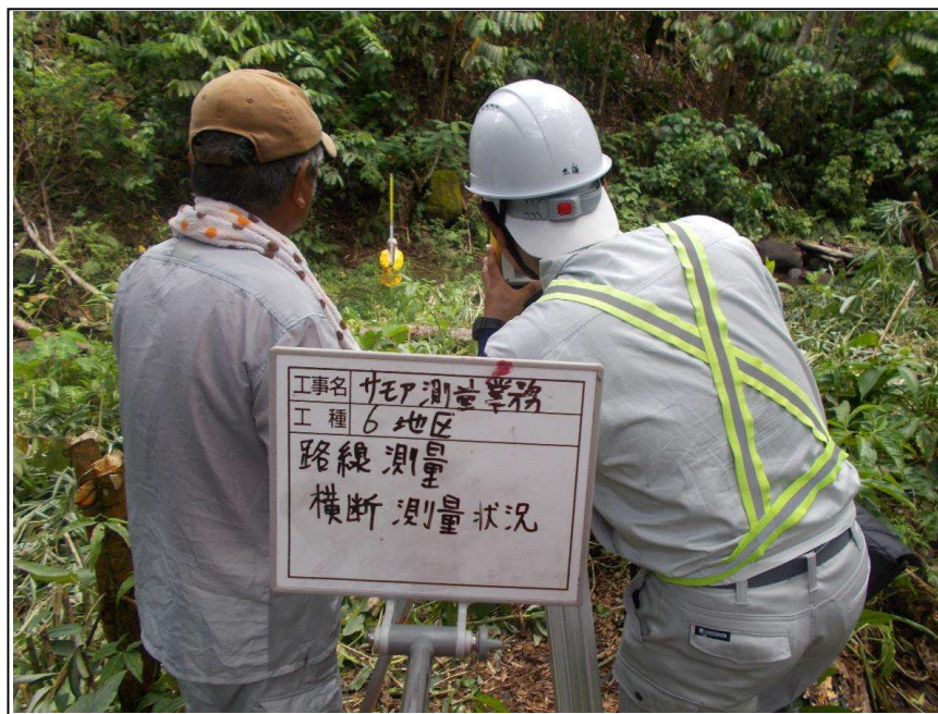
横断測量状況
