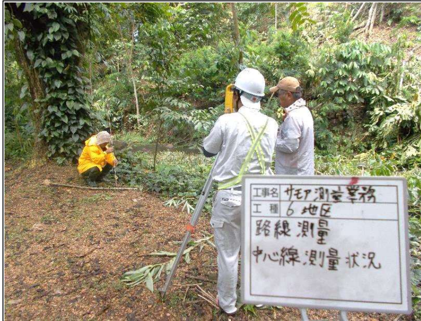
中心線測量状況
