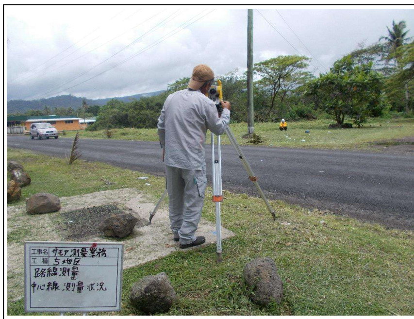
中心線測量状況
