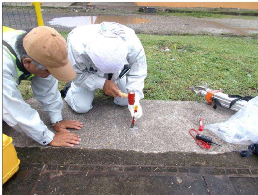
簡易基準点設置状況
