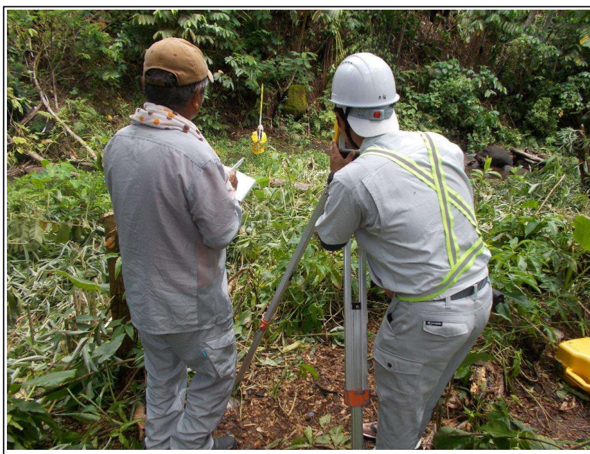
縦断測量状況
