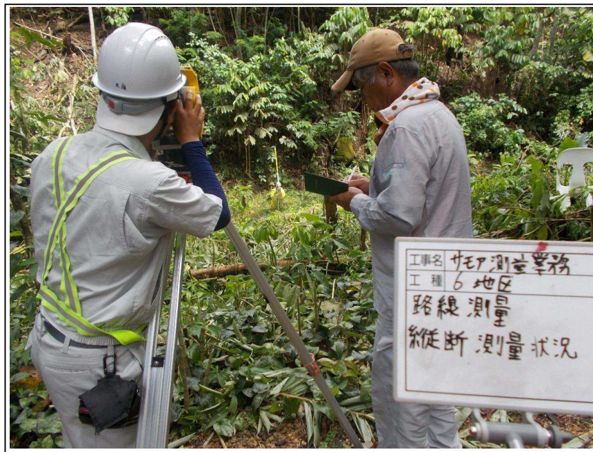
縦断測量状況
