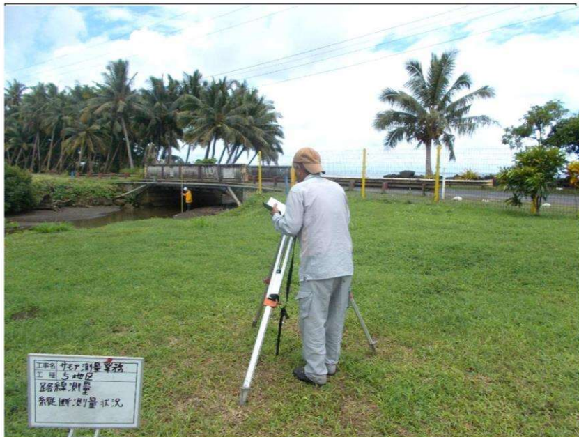
縦断測量状況
