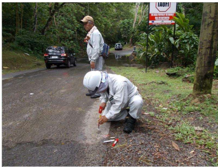
簡易基準点設置状況
