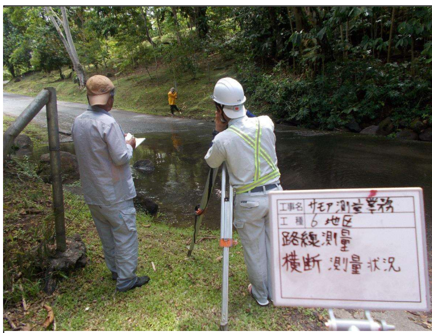
横断測量状況
