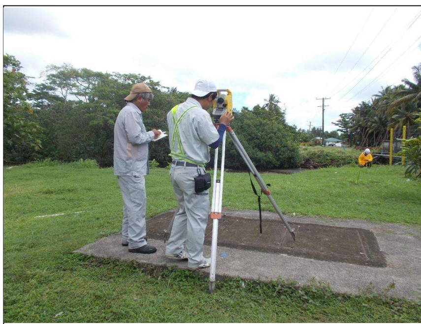
中心線測量状況
