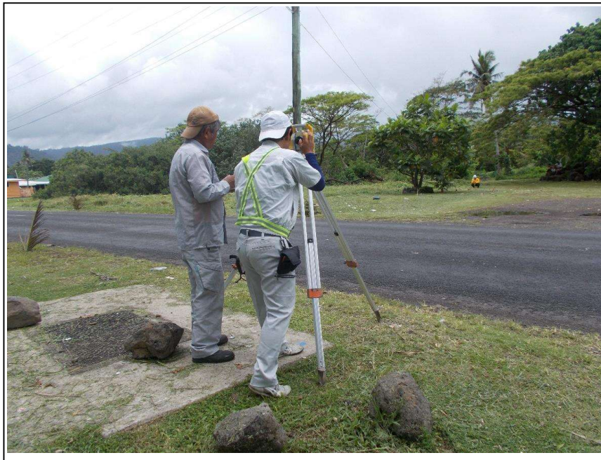
中心線測量状況
