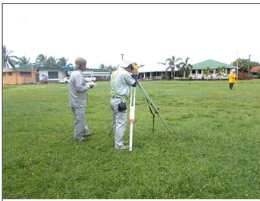
横断測量状況
