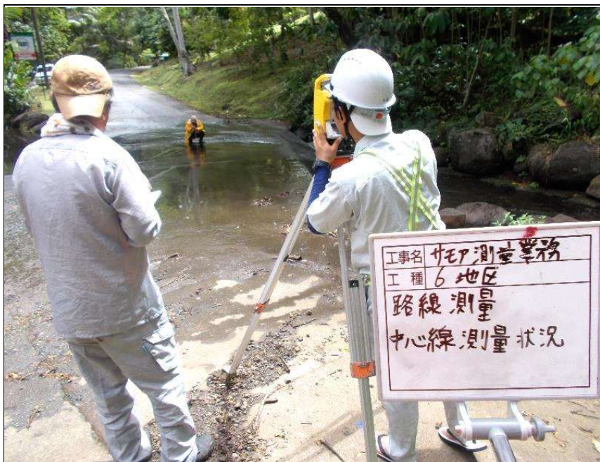
中心線測量状況
