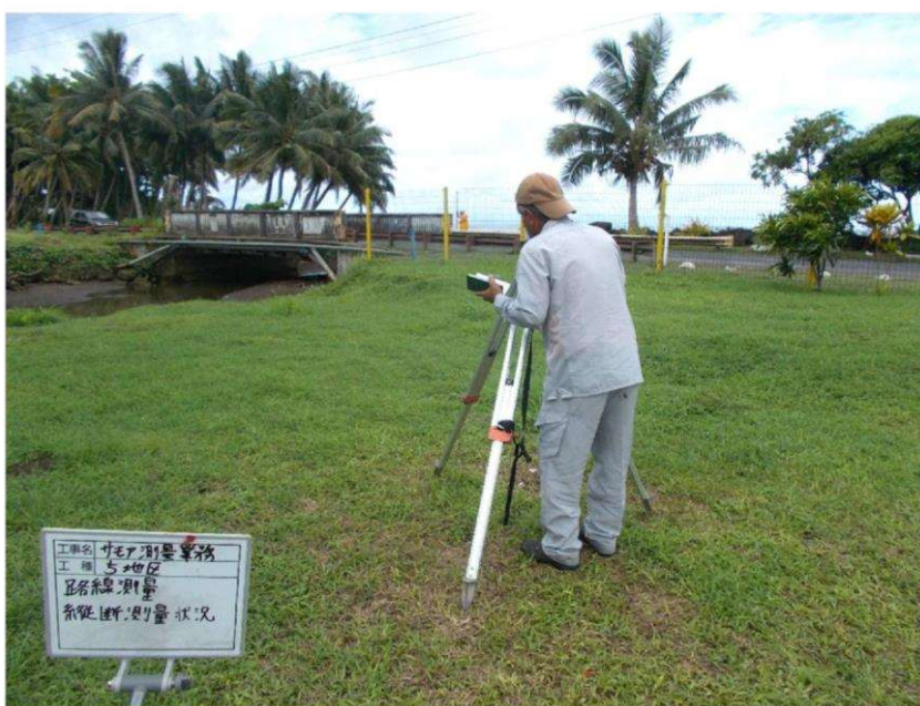
縦断測量状況
