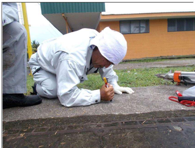
簡易基準点設置状況
