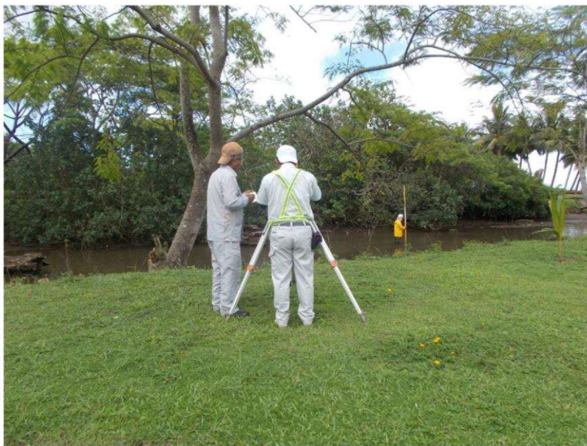
縦断測量状況
