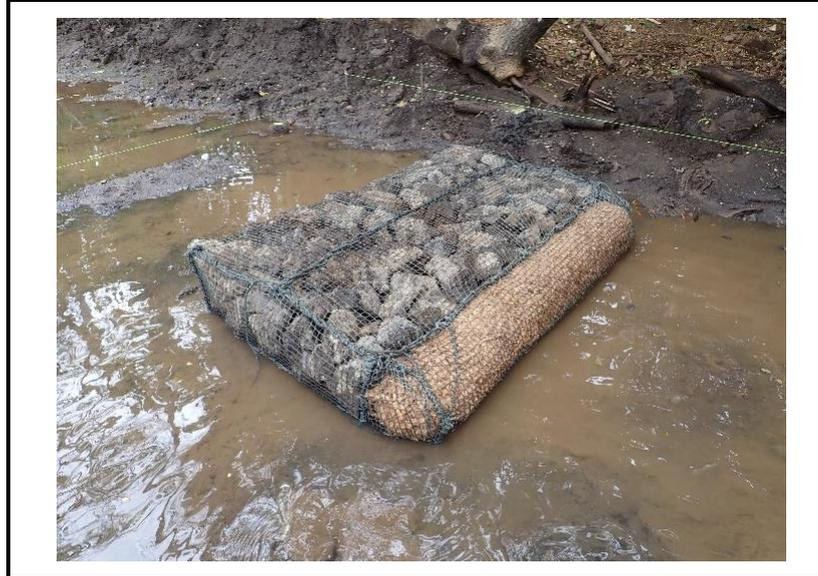
写真 3.1 バイオログフィルター付きフィルターユニットろ過施設
