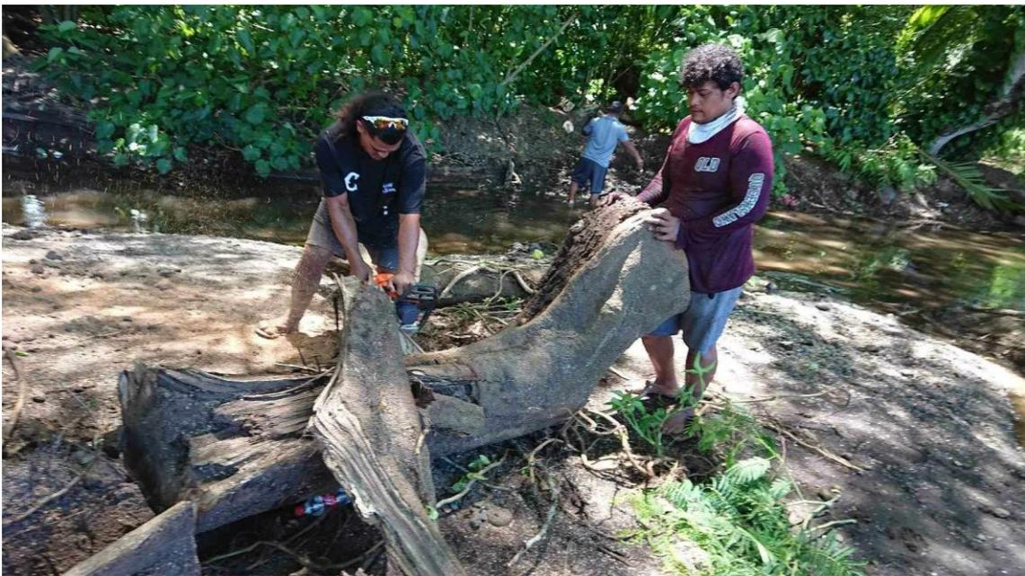
写真4 巨大流木を吊り上げるための切断作業状況
