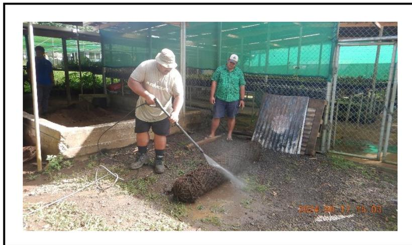
**写真 3.14 MNRE の職員によるバイログフィルターの洗浄状況**
