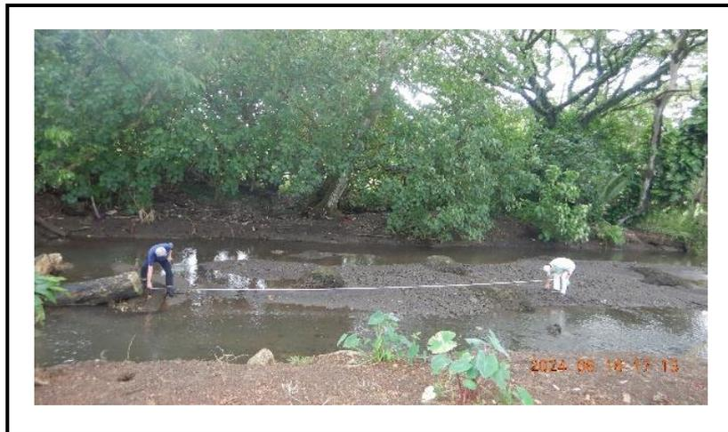
写真 3.2 ろ過施設によって捕捉された堆積土砂の簡易測量
