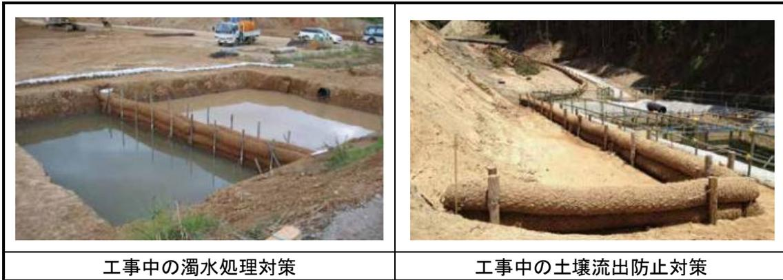
写真 2.2 バイオログフィルターによる工事中の濁水対策及び土壌流出防止対策
