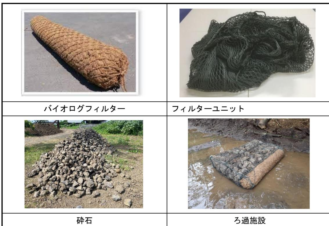
写真2 バイオログフィルター付きフィルターユニットろ過施設の構図
