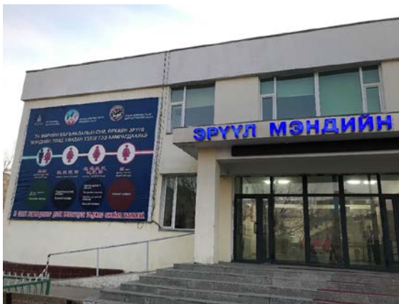
オルホン県保健局公衆衛生センター 外観
