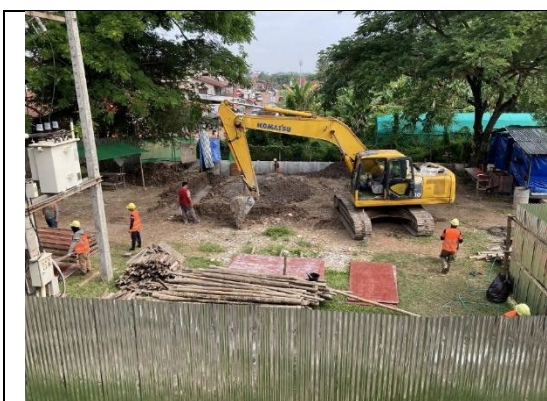
工事開始当初の掘削の様子
