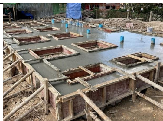
コンクリート施工の様子
