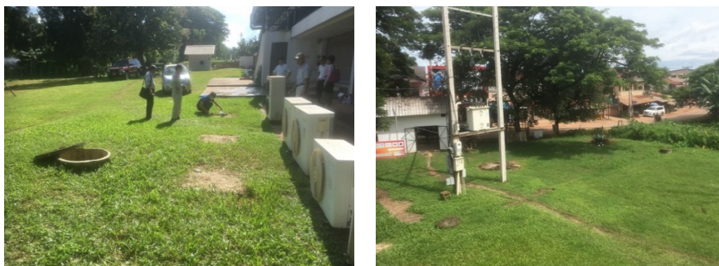
図 6 ラオス大学・フードコート 設置候補場所の様子
