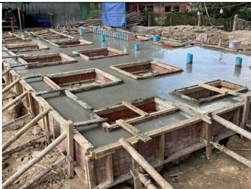
コンクリート施工の様子
