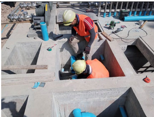
設備施工の様子
