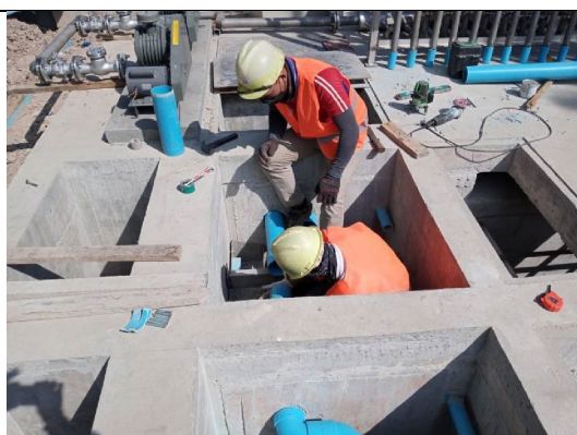
設備施工の様子
