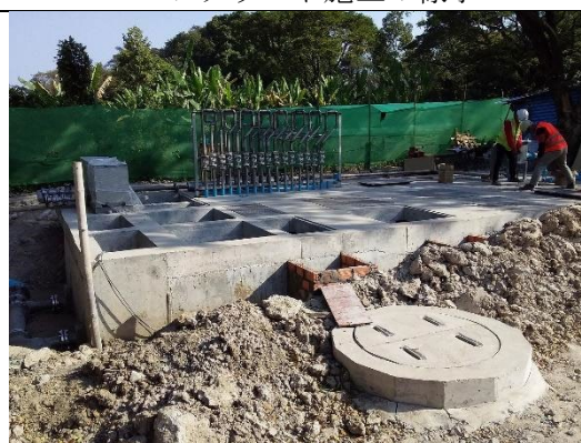
2023 年 1 月末時点の施工状況
