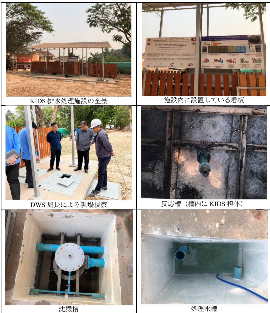
図 10 ラオス大学フードコート敷地での KIDS 排水処理施設の施工の様子
