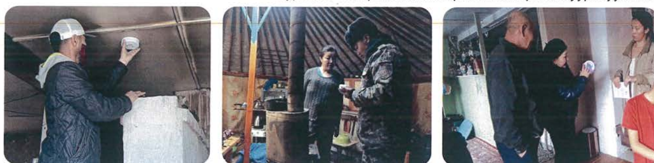
Зураг 10 Угаарын хийн мэдрэгч төхөөрөмж суурилуулалт
