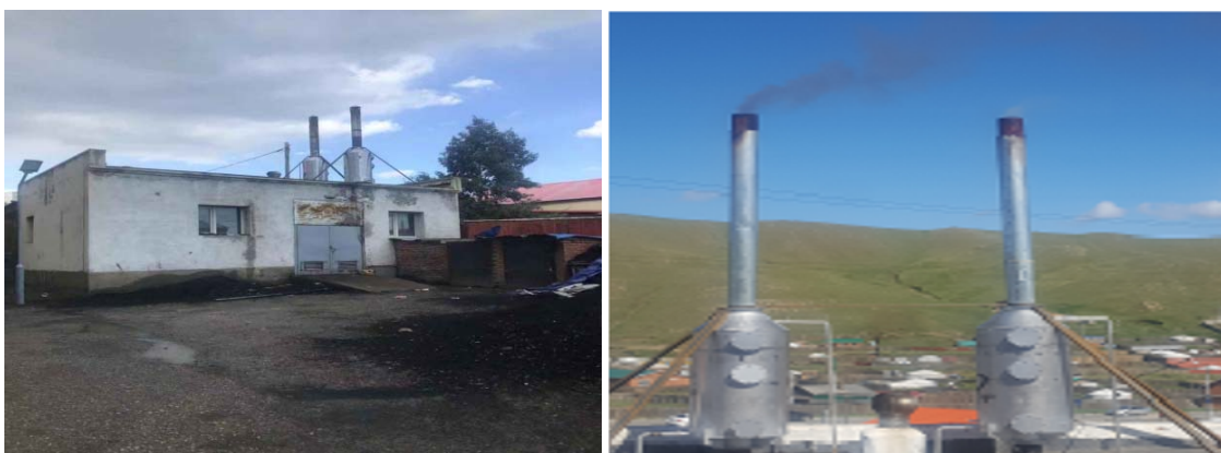
Зураг 3. Халаалтын зууханд утаа шүүгч суурилуулсан байдал
