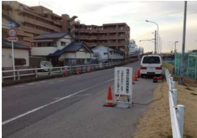
図 1. 計測機器設置例（測定車両と看板）
