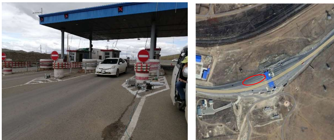
図 2-2(1) 調査地点（西の料金所）
