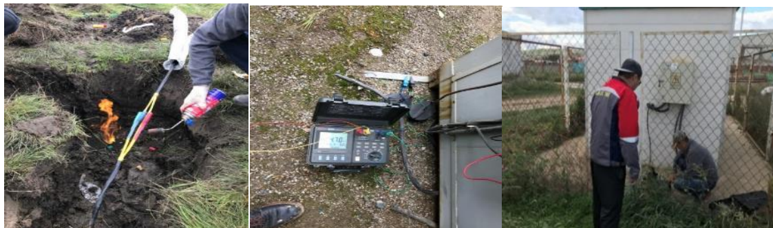
図-1 測定局の電気修理工事の模様
