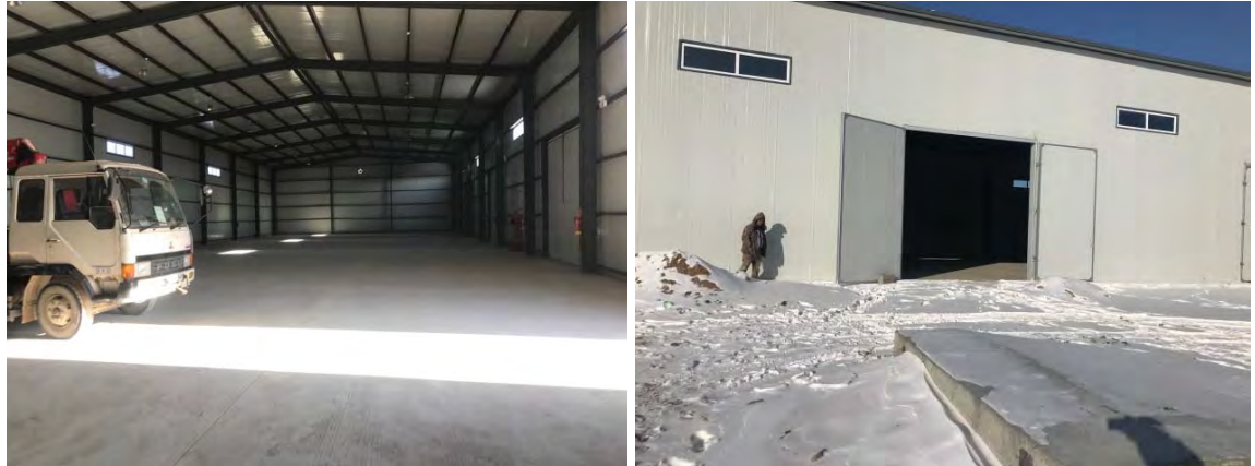
図-2. 改良燃料貯蔵倉庫
