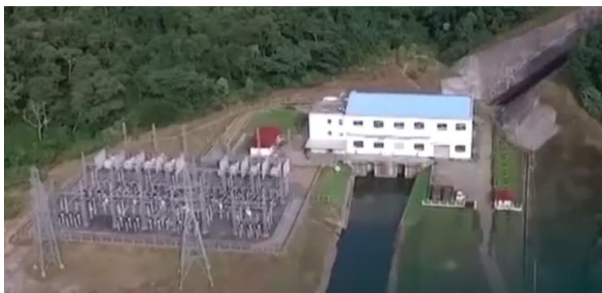
(a) 発電所遠景
