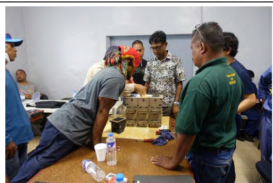
4-遮断器（ACB）点検実習
