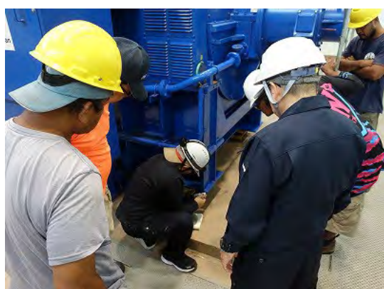
1/24 振動測定状況
