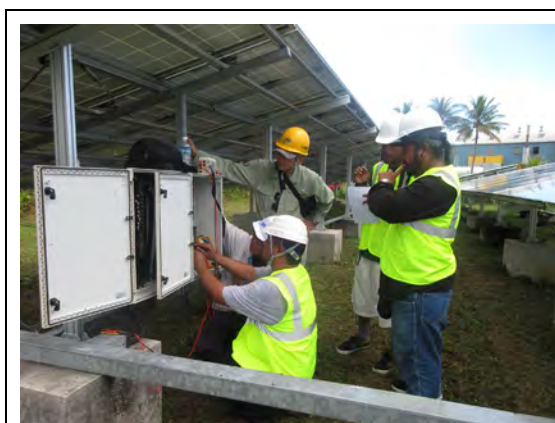
太陽光発電設備点検実習①
