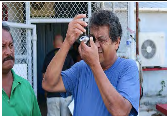
蓄電池点検（比重測定）
