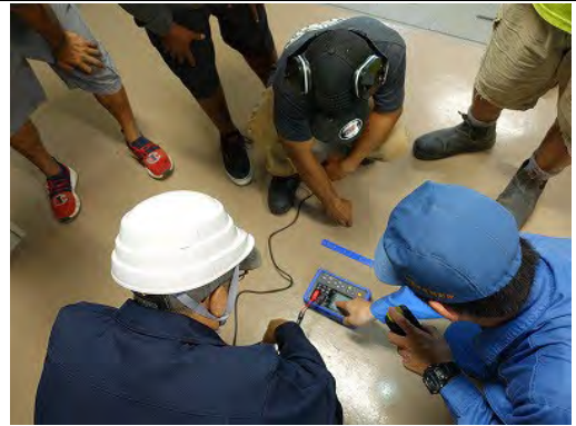
1/26 バッテリー点検状況
