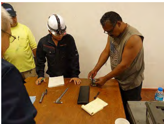
1/26 VCB 点検状況
