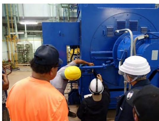
1/24 振動測定状況
