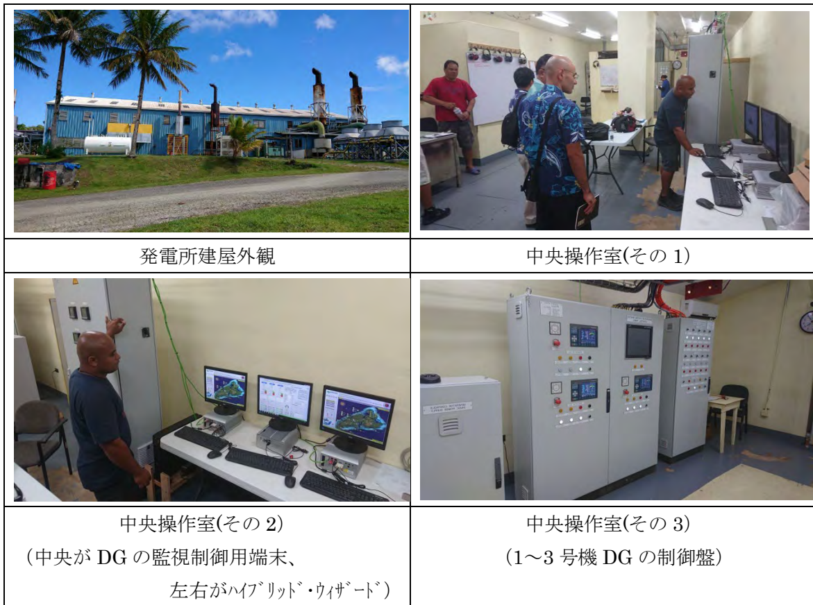
写真ヤップ発電所
