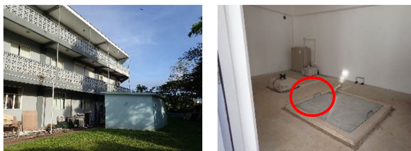
図 3.2.9. VMGD 本部地震計室内の設置想定場所（赤丸；強震計台付近）
