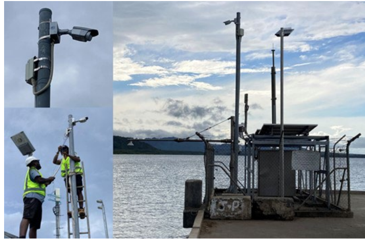
図 3.2.26. リツリツ潮位計測サイトへの津波監視カメラ設置
