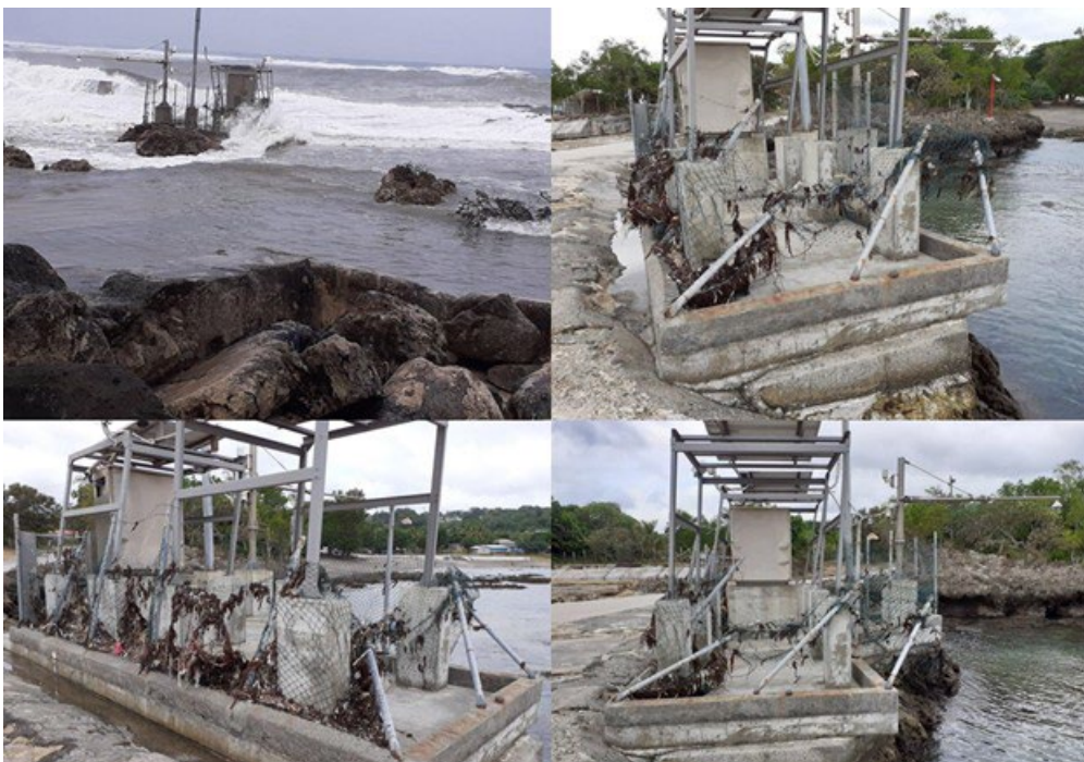
図 3.2.22. サイクロンの高波で施設が被害を受けたレナケル潮位計測サイト
