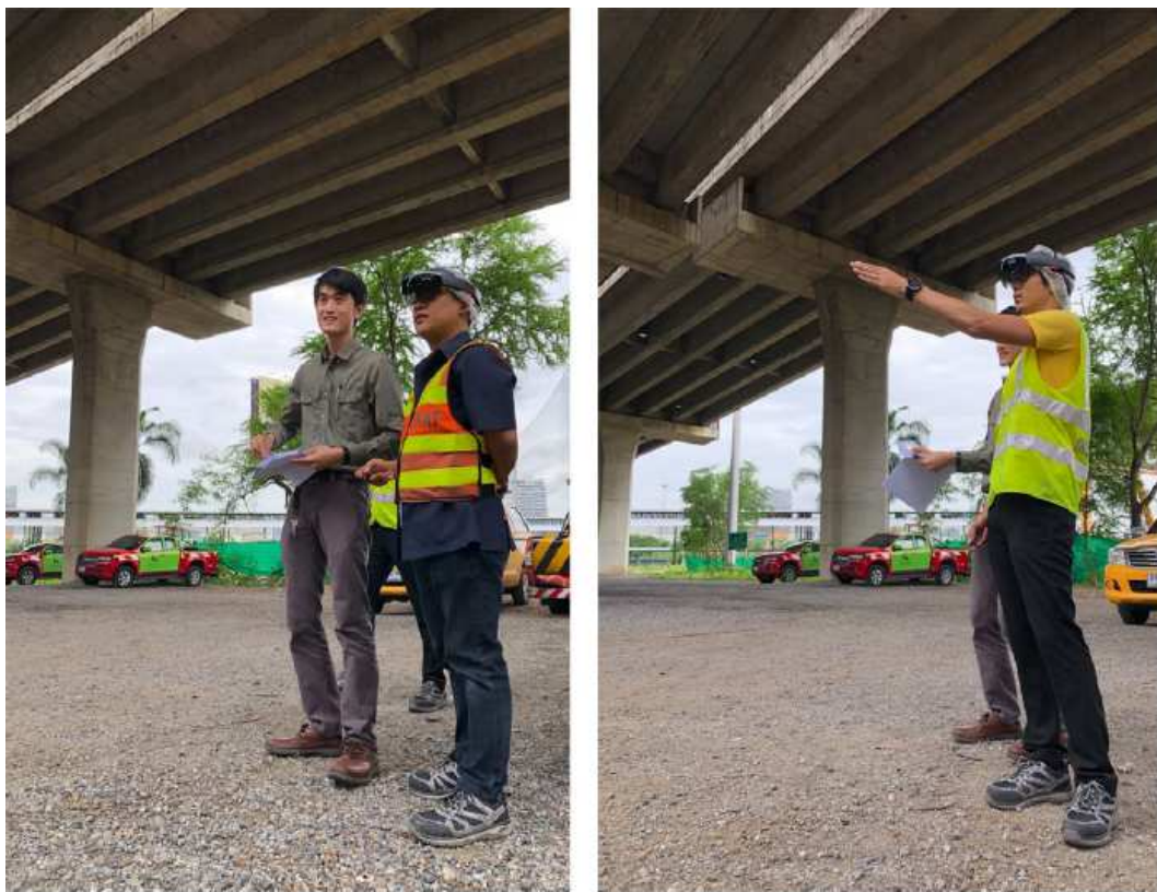
写真 3. 2. 2 高速道路構造物の点検
