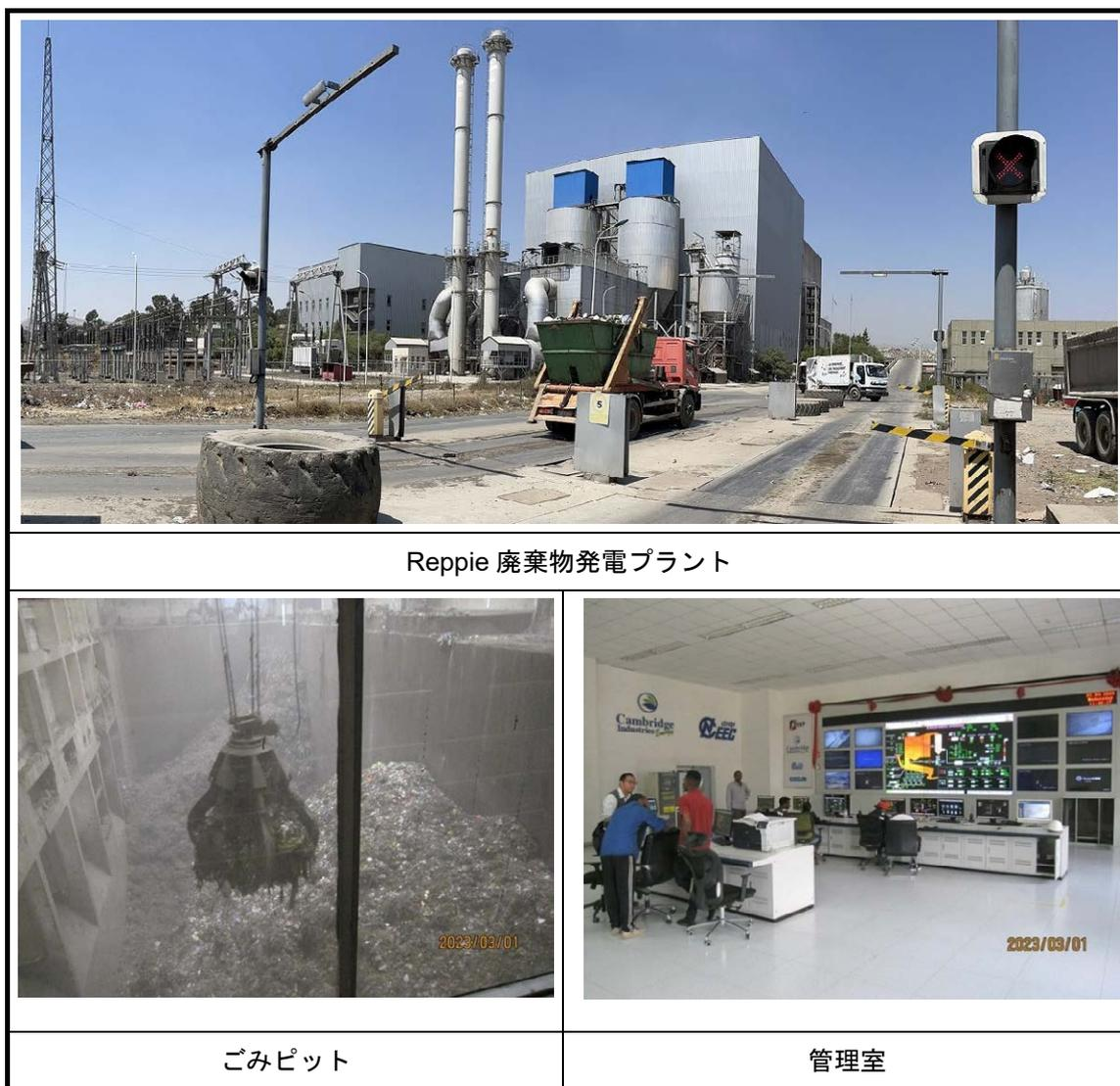
しかしながら記録を見ると、最終処分場への搬入ごみ量に対する焼却量の割合は 2020 年には 56% で、2021 年の 33% から 2022 年には 22% に減少している。この数字は、計画通りに廃棄物が焼却されているのではなく、焼却が不安定でかつ焼却量が少ないことを示している。施設の関係者によると、効率的に発電するには廃棄物の発熱量が低すぎ、発電量に比べてランニングコストが高すぎるのが問題となっている。ごみピットのオペレーターによると、水分を除去するのに受入から約 5 日かかることが明らかとなっている。含水率は 74.3% と説明されており、無処理
