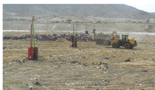
ガス抜き管付近の電灯の様子
