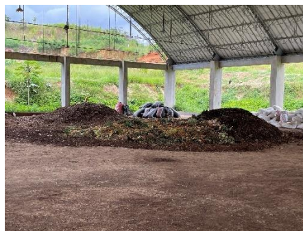
Moyobamba 処分場のコンポスト設備
