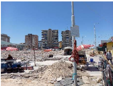
マラティヤ市内の被災地の様子
