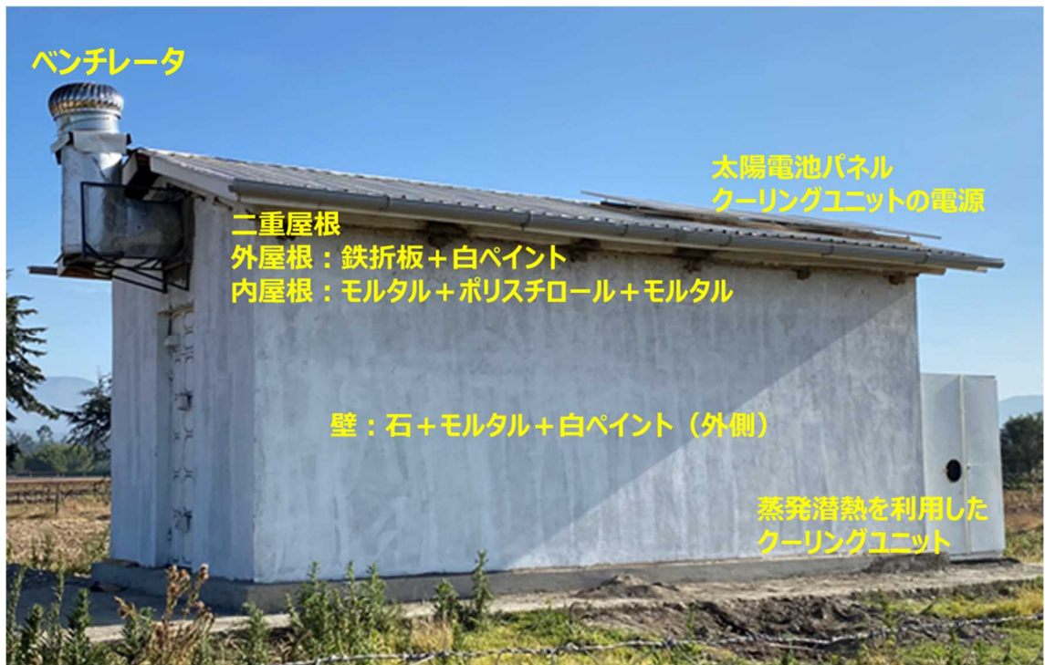
図 1-8 現地実証試験施設
