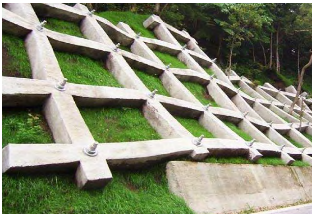
図 8.6-40 グランドアンカータイプのアンカー工
