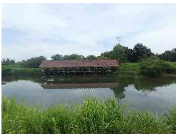
今年経営難でやめてしまったアヒル小屋(池の上)
