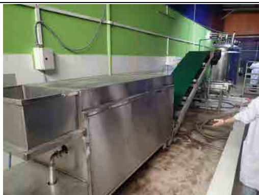
BSF 幼虫を搬送する設備
