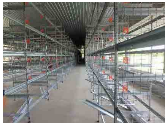
新設中の養鶏場(中国のシステム導入)
