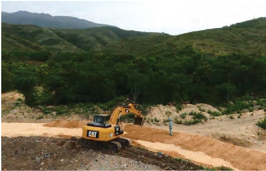
Fuente: Equipo de expertos de JICA, Rehabilitación Vertedero Azua, RD. 2017.- Foto 6. Instalación de Dique para un área de depósito de residuos
