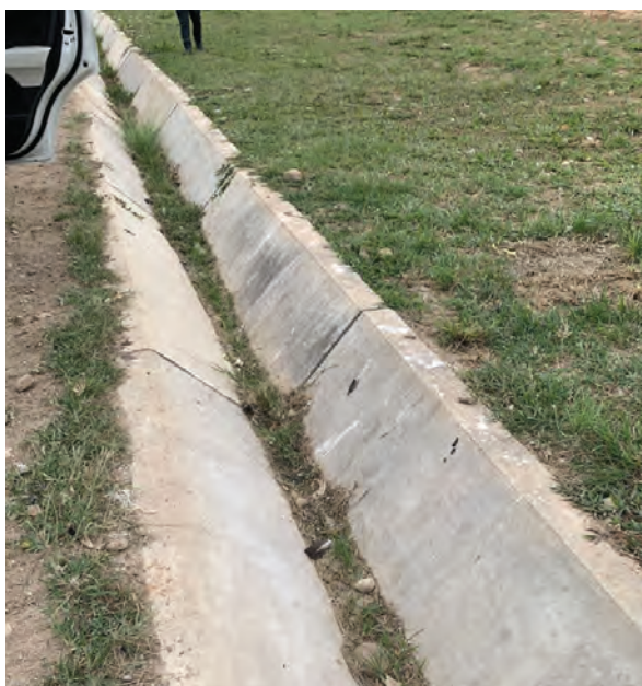
Foto 10. Instalación para drenaje de aguas pluviales en un SDF en hormigón. –
