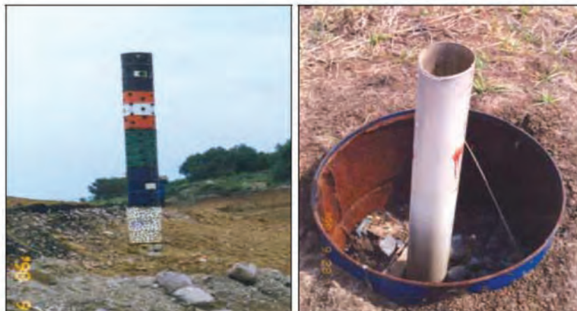
Figura 37: Ejemplo de una instalación sencilla para ventilación de gases
