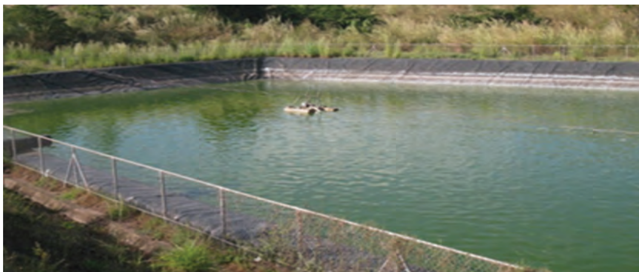
Foto 5: Laguna de lixiviados en el Relleno Sanitario de ASINORLU, Santa Rosa de Lima, El Salvador
