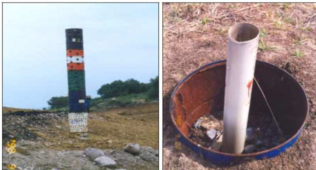
Figura 2-36 Ejemplo de una tubería de ventilación de gases
