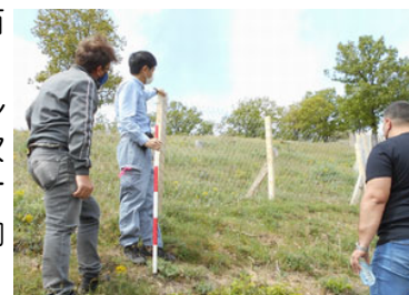
防護フェンス設置状況の確認
