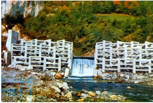
Слика 4-3 Класична отворена насипана брана во Тетово (лево) и комбинирана насипана брана (десно)
