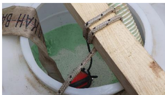
Фото 18: Поставувањето на пумпи во резервоарите
