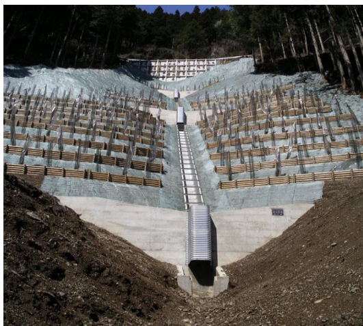
Слика 3-14 : Изградба на ридски канал
