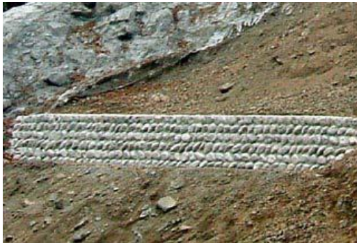
Слика 3-7: Материјали за потпорни ѕидови: потпорна конструкција со влажна ѕидарија (лево) и потпорен ѕид со челична рамка
