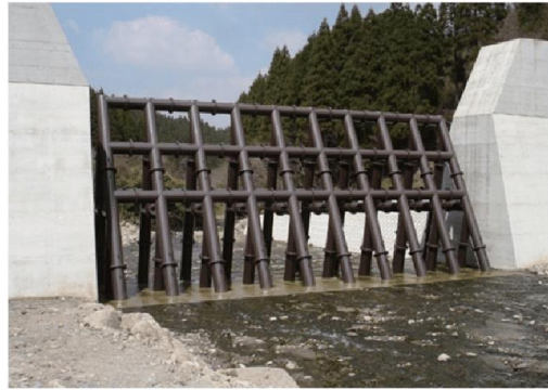
Слика 4-3 Класична отворена насипана брана во Тетово (лево) и комбинирана насипана брана (десно)
