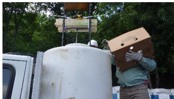
Фото 16: Мешалката се поставува на горниот дел од резервоарот
