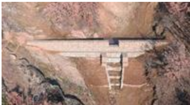
Слика 4-1 Насипана брана со габиони во Лисиче и Радовиш, изградени и прикажани во рамки на проектот за Еко-НПК во Северна Македонија
