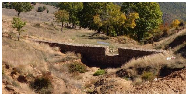
Слика 4-1 Насипана брана со габиони во Лисиче и Радовиш, изградени и прикажани во рамки на проектот за Еко-НПК во Северна Македонија
