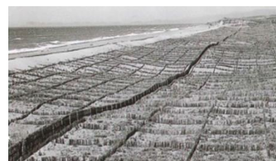
Конструкција за стабилизација на песокот направена во 1955 г.
