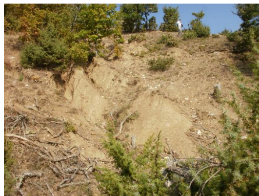
Слика 16: Место со напредна ерозија, каде се разгледува опцијата за поставување насипана брана
