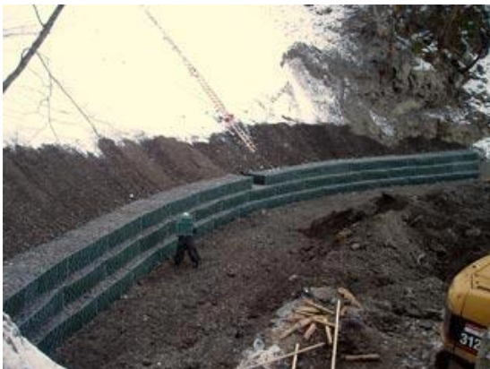
Слика 3-8: Материјали за потпорни ѕидови: потпорни ѕидови од габиони (лево) и потпорни ѕидови од трупци (десно)
