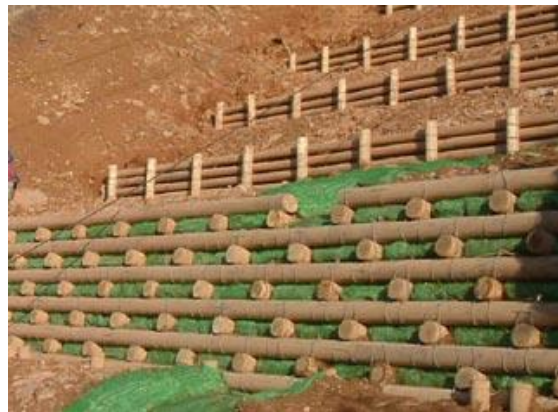
Слика 3-8: Материјали за потпорни ѕидови: потпорни ѕидови од габиони (лево) и потпорни ѕидови од трупци (десно)
