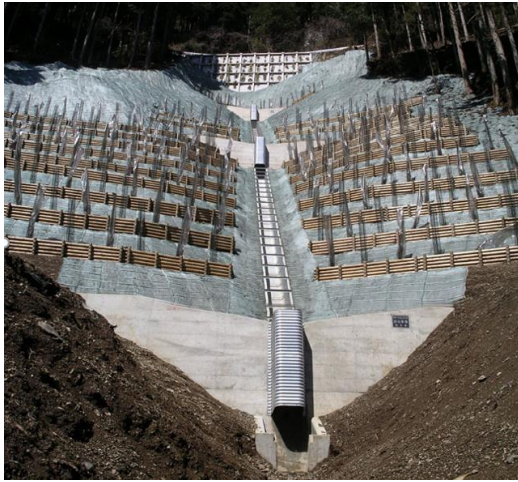
Слика 3-5: Потпорен ѕид во комбинација со ограда и со канали на ридот
