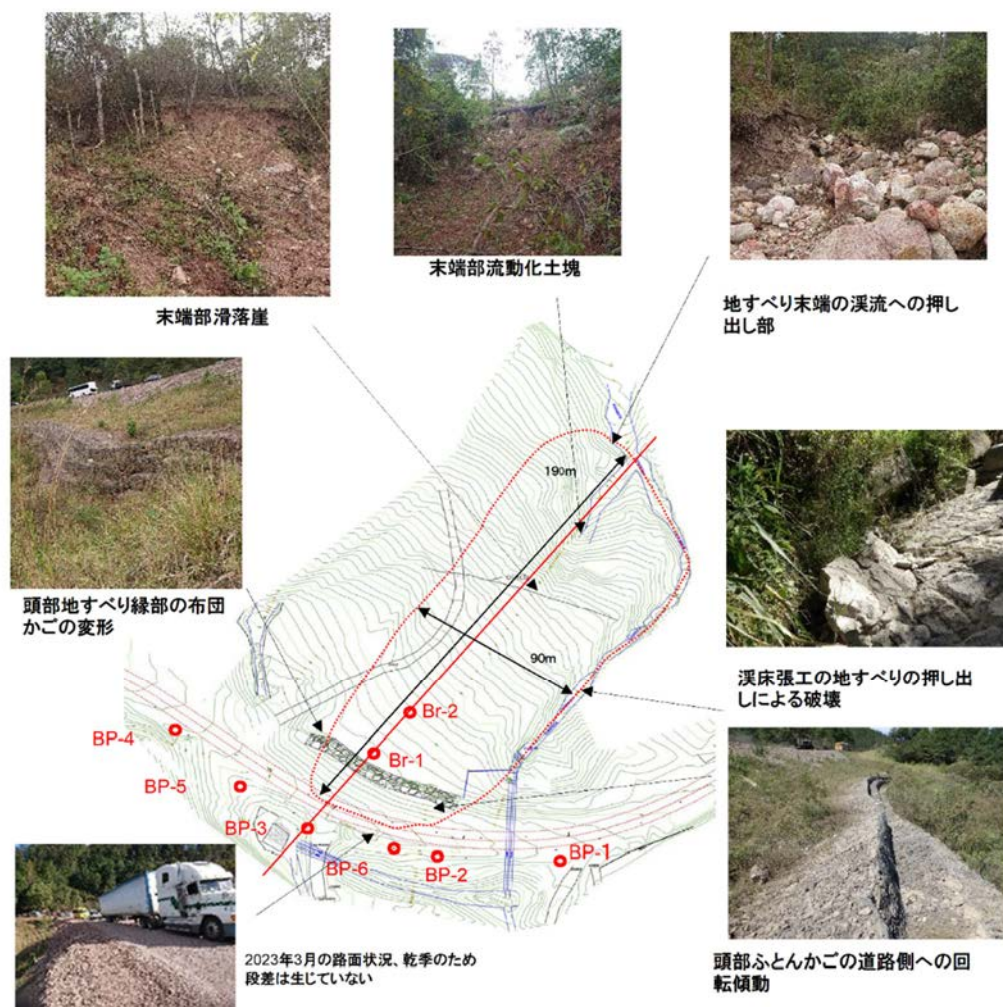
図 2.8.1 CA6 の 160+00~162+00 に変状を生じている地すべり範囲
