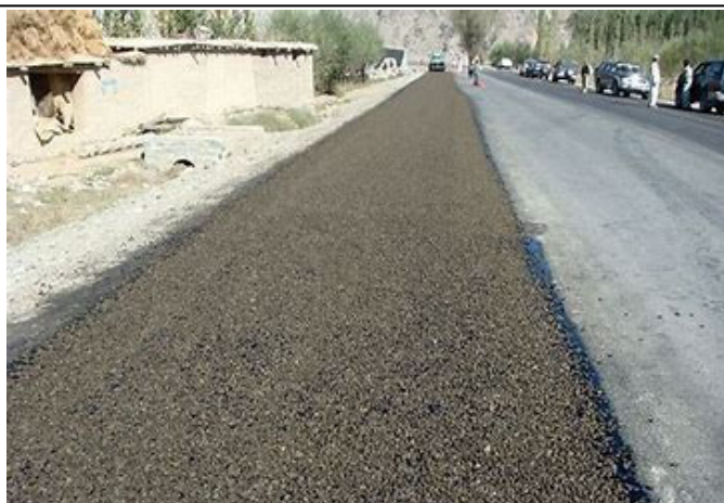
写真 2.7.2 DBST による舗装表層の路面被覆
