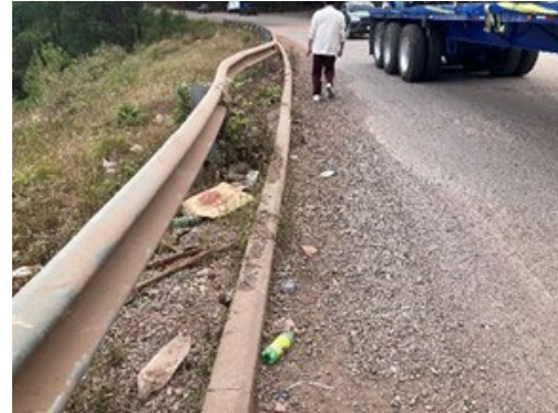
【ガードレールの変形】
