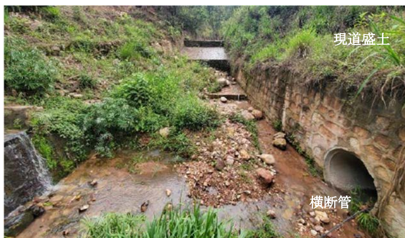
写真 3.2.1 土砂の流入・堆積により閉塞した水路
