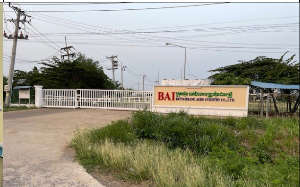
操業を停止している澱粉製造工場 (Battambang Agro Industry) (バタンバン州)
