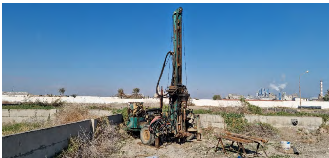
図 BH 1 掘さくリグ
