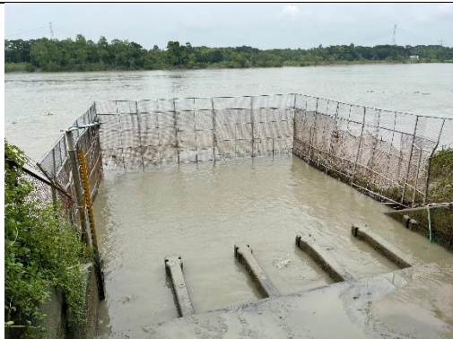
モハラ浄水場取水口
