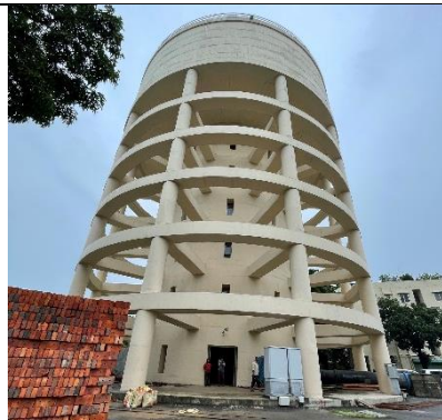
ナシラバッド高架水槽
