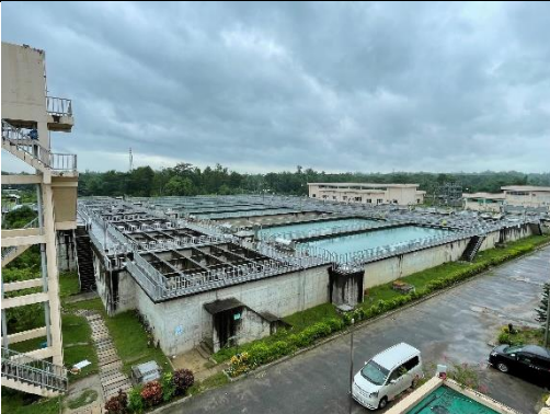
カルナフリ浄水場
