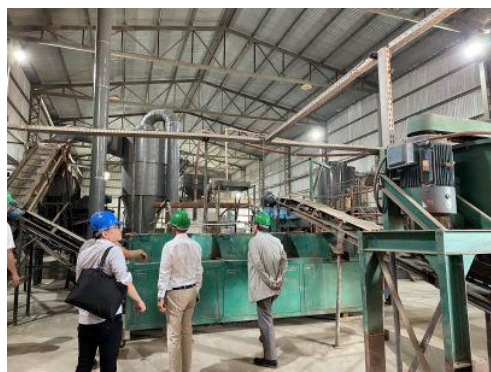
コンポストプラント機材視察（ルケ市）
