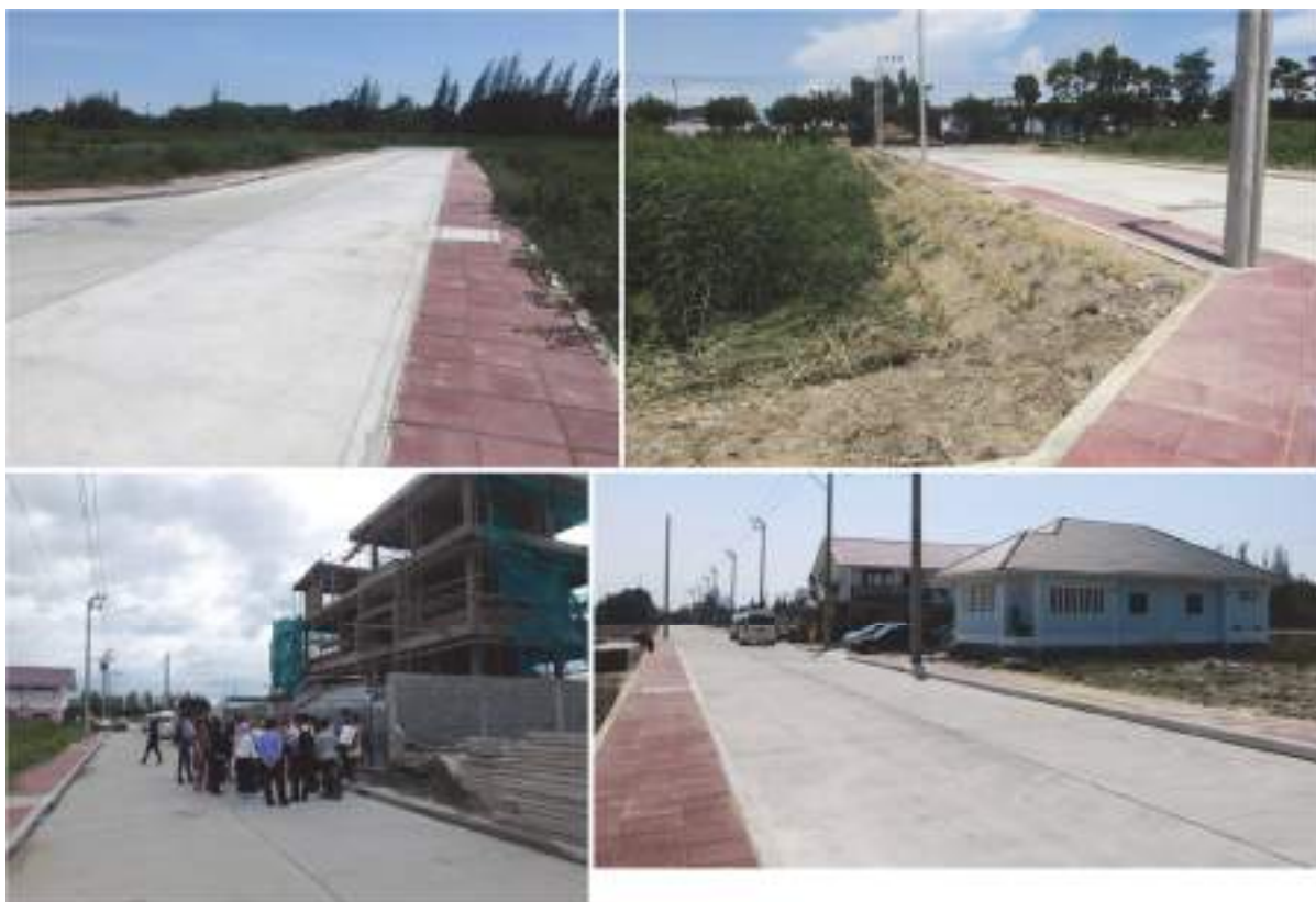
図 2-10 ラマ 9 世公園地区 完成後の状況
