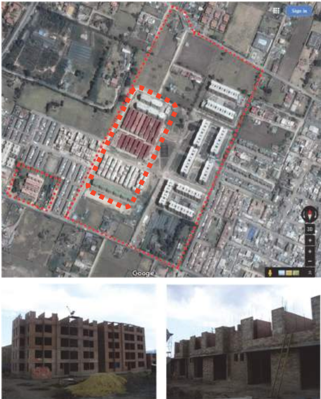
図3-9 開発後の状況 [写真上2017年、写真下(建設中)2014年]
