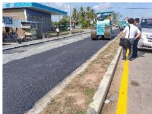
国道4号線：道路改修工事の現場を視察
