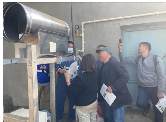
Green Lips 現地適合性試験用機器据付
