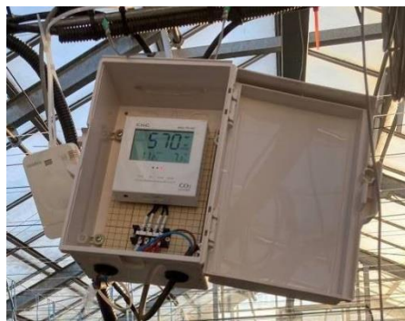
図 2-5 CO 2 コントローラ及びハウス環境測定/管理
