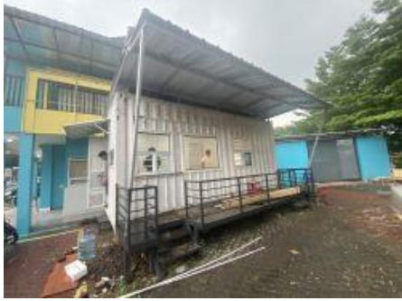
蓄電池メーカーH社
