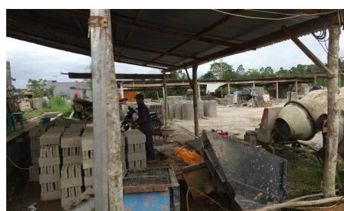
パガー・アラム市生コン工場
