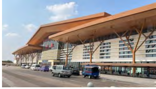
ຮູບ 2.2-3 ທາງລົດໄຟລາວ-ຈີນ (ສະຖານີນະຄອນຫຼວງວຽງຈັນ)
