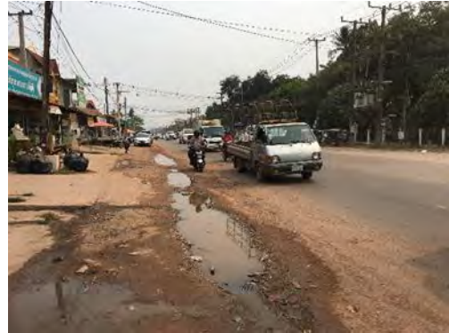
ຮູບ 11.3-15 ຮ່ອງລະບາຍນ້ຳຕາມແຄມທາງບໍ່ພຽງພໍ
