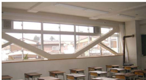
図 3.3.6 学校施設の耐震補強事例
