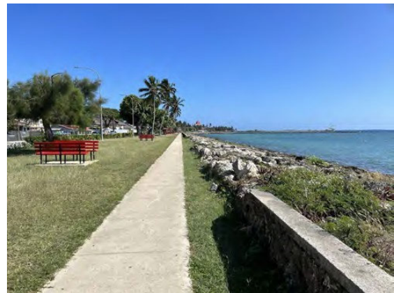
写真 4.1.14 左の写真位置から約 60mが崩壊
