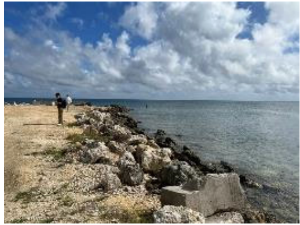
写真 2.7.26② 東側石積護岸の延長約 130m
