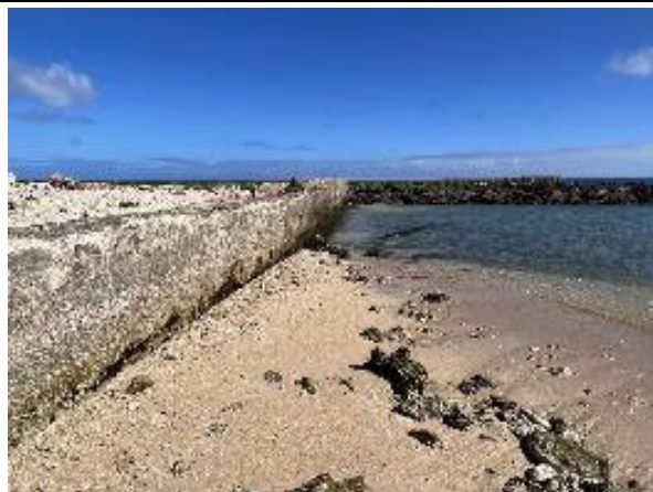
写真 2.7.23⑥ 旧港コンクリートブロック岸壁
