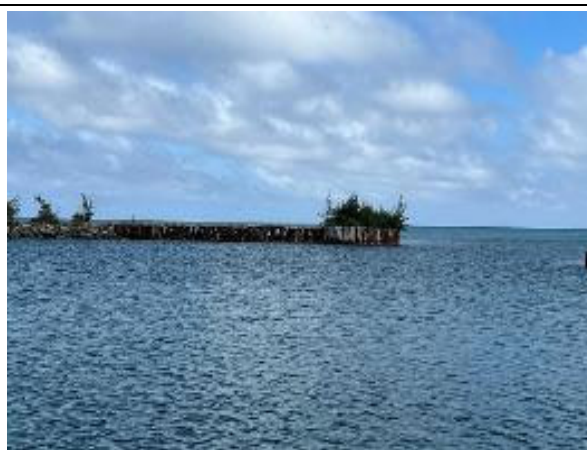
写真 2.7.34 ⑩ 海中の防波堤
