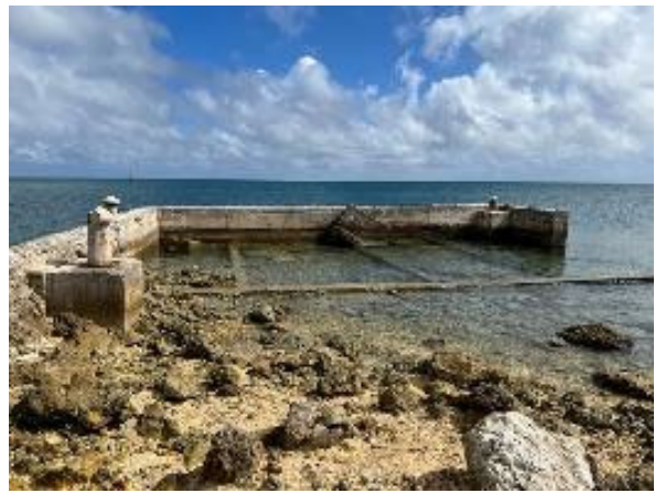
写真 2.7.28④ ケーソン式混成堤
