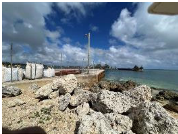
写真 2.7.29⑤ 石積護岸奥に矢板岸壁が見える
