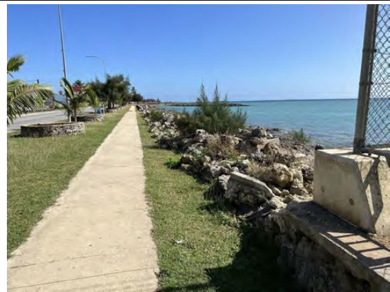
写真 4.1.16 国内船ターミナル・フェンス手前
