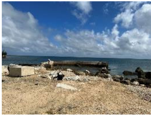
写真 2.7.27③ 北側埠頭突端部
