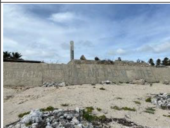
写真 2.7.3 この基礎上のリゾートが破壊された
