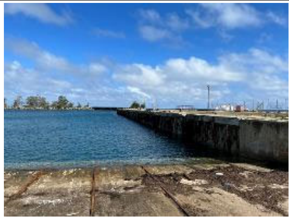
写真 2.7.30⑥ ランプ部から矢板岸壁を望む
