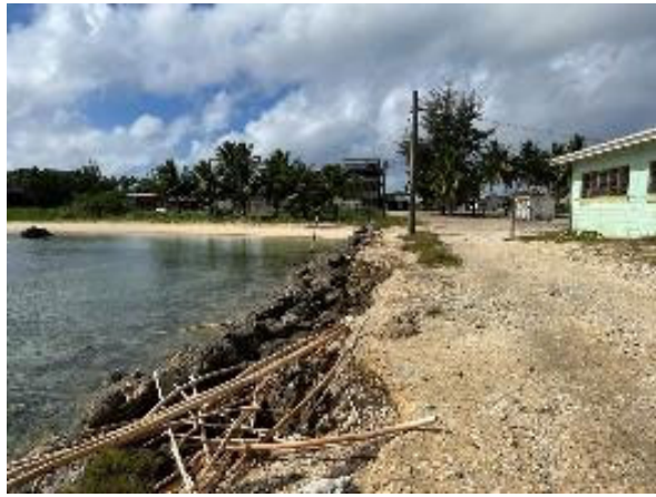
写真 2.7.25① 北側埠頭東側石積護岸工
