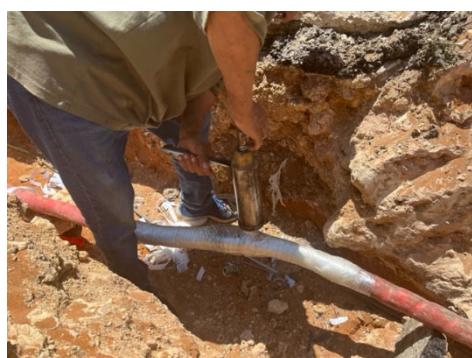
図 5.3-20 左:地中ケーブルの接続工事、右:エポキシリジン
