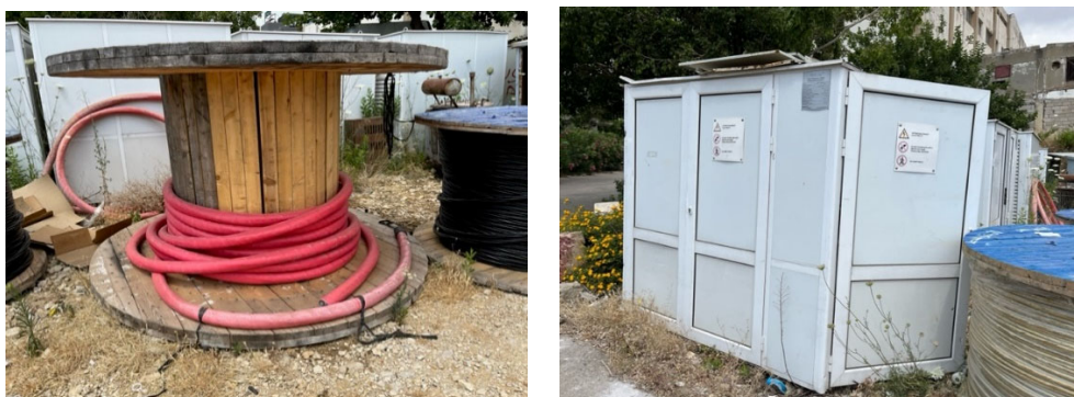
図 5.2-3 左:地中ケーブルのドラム、右:仮設プレハブ変電所
