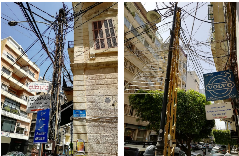
図 5.1-6 ベイルート市内の低圧柱
