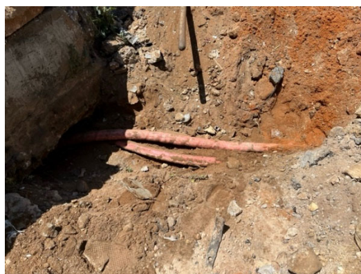
図 5.3-19 中圧の地中ケーブルの埋設状況
