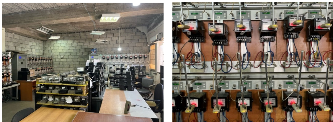
図 5.3-27 左：計量装置試験室図、右：撤去計量装置の精度検証試験
