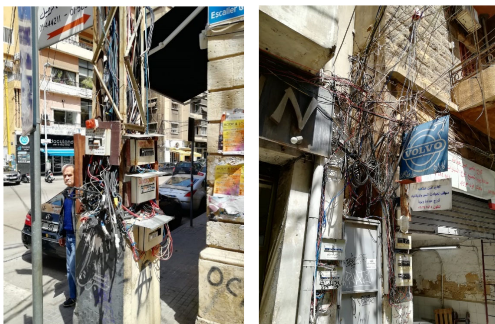
図 5.1-7 民間発電事業者の設備
