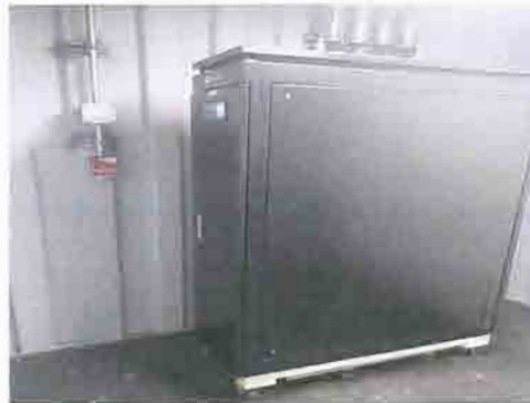
指摘事項 9 電気室壁断熱材未施工
