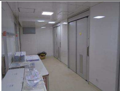
ICU コンテナ内部廊下
