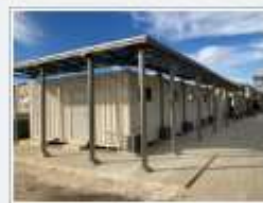
コンテナICU外観
