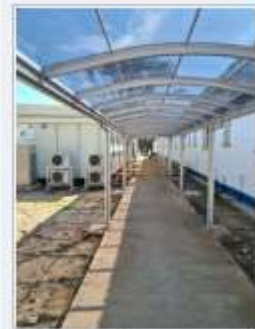
プレハブICU外観
