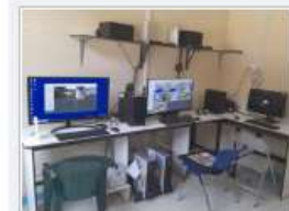
改修されたICU病棟（モニタリングエリア）
