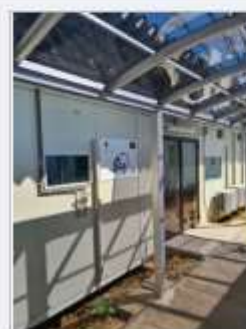
プレハブICU外観
