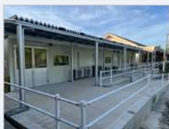
プレハブICU外観
