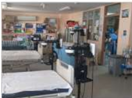
供与機材（遠隔ICUシステムを含むICT機材：写真中央のベット横機材）が設置された病室
