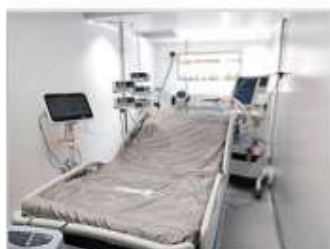
オーラン総合病院に建設されたコンテナICU（内部）
