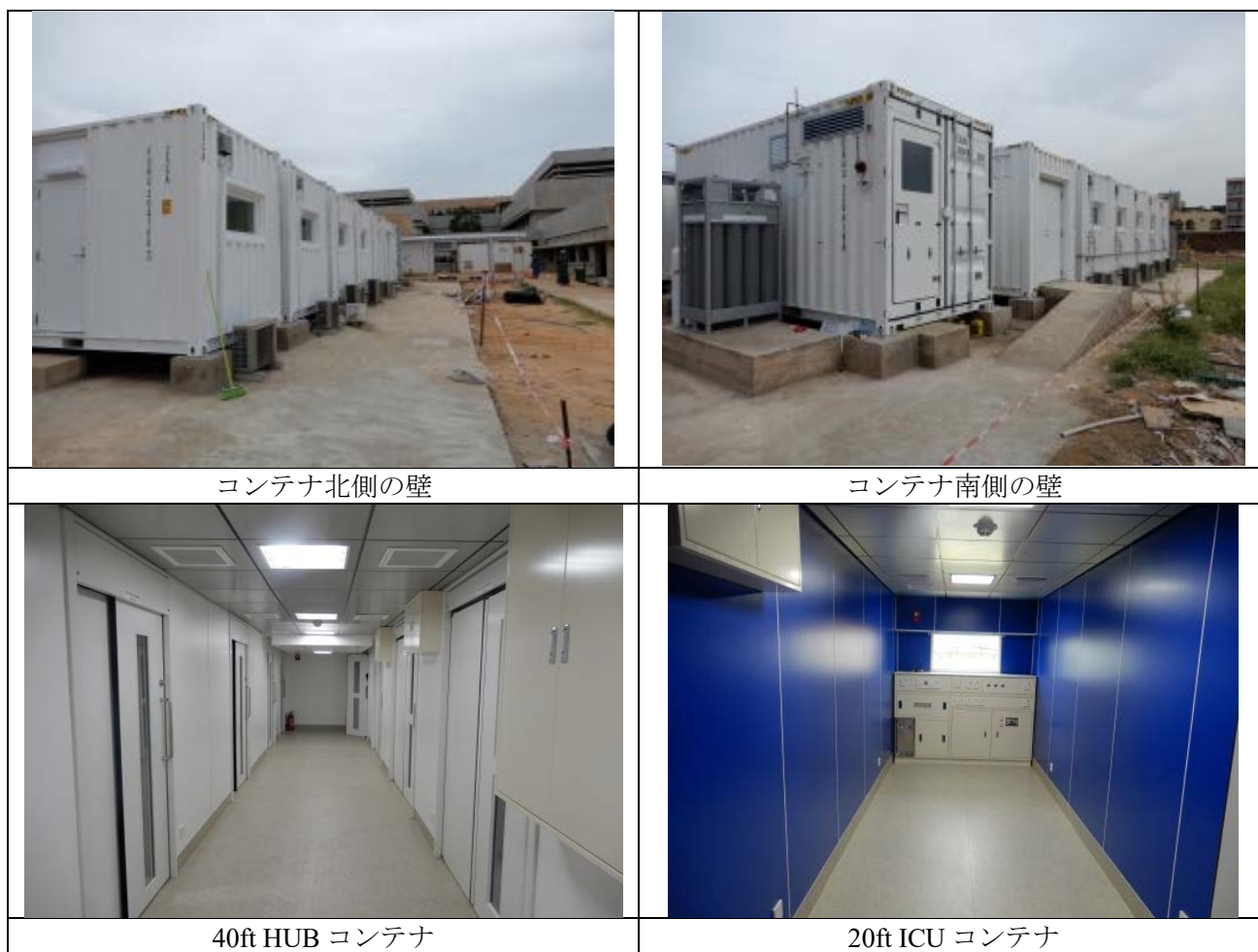
図 3-57 完成したコンテナ ICU (セネガル)
