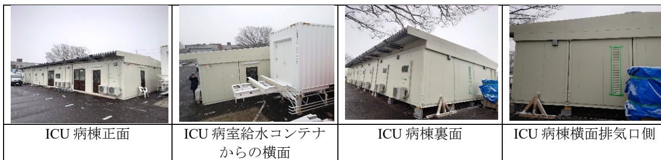
図 3-36 プレハブ ICU の工場出荷前検査（ケニア）
