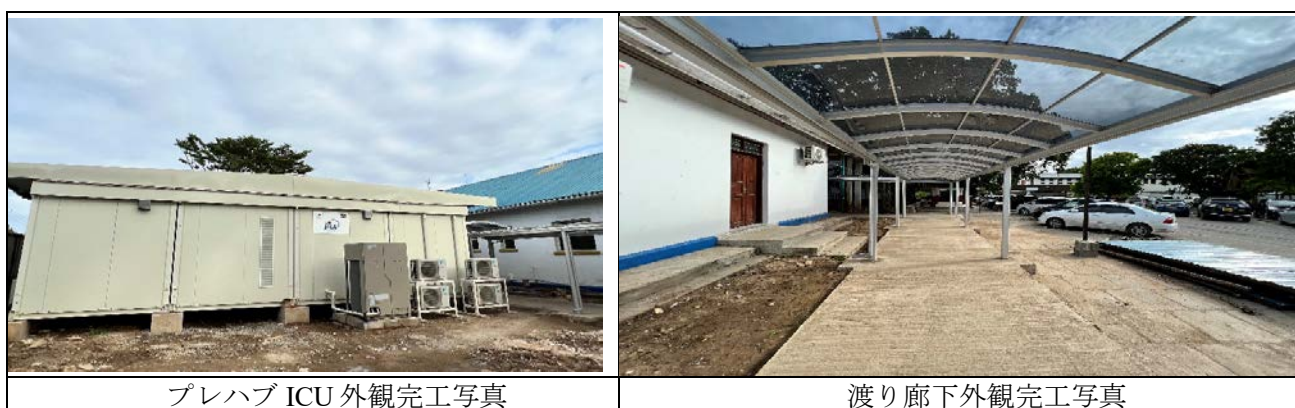
図 3-37 プレハブ ICU の完工検査（ケニア）
