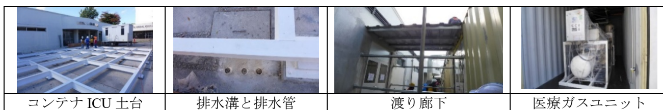
図 3-89 施工途中（メキシコ・オーラン総合病院）
