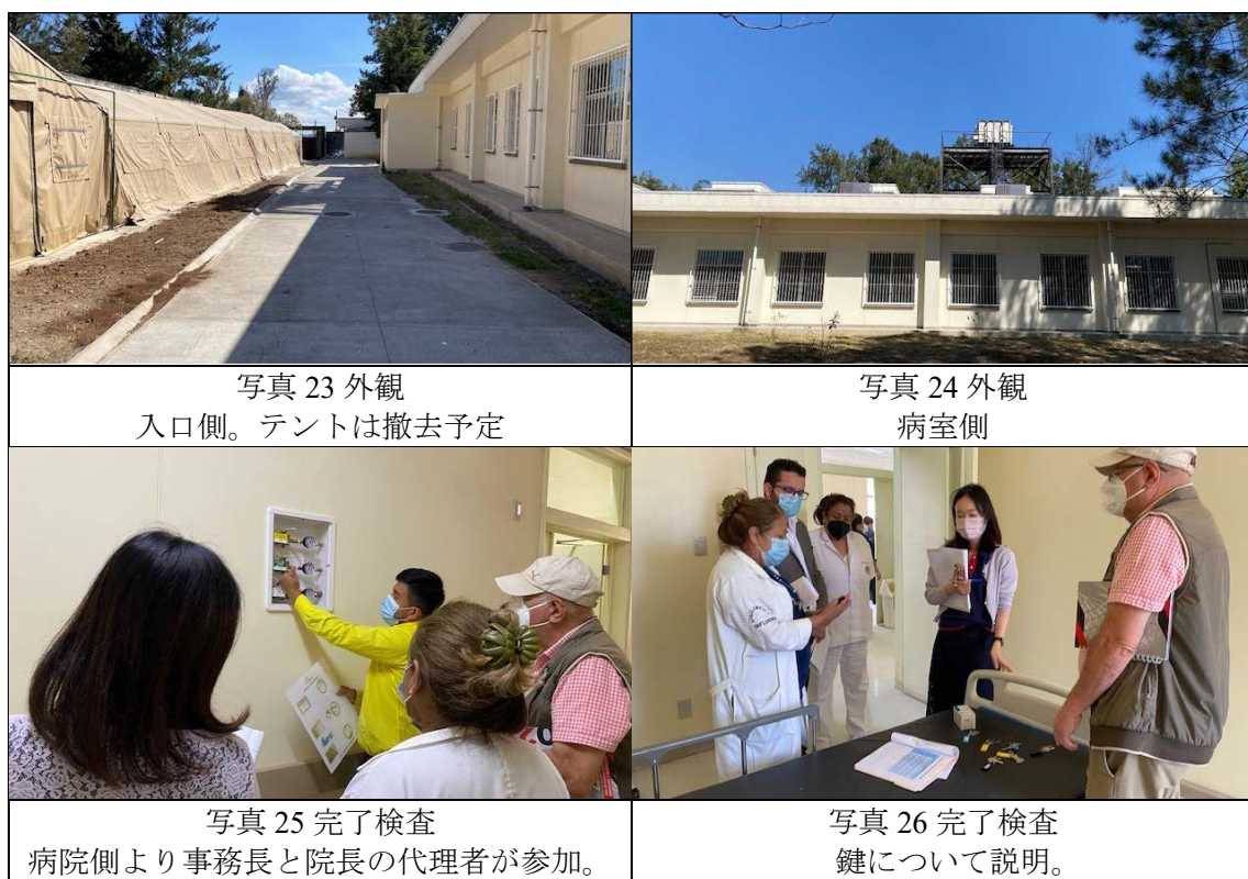
図 3-75 竣工検査写真
