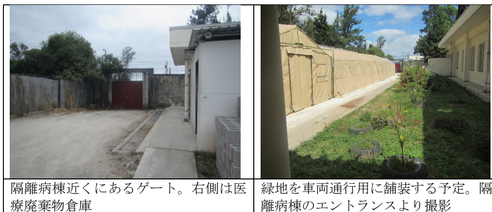
図 3-74 敷地現況写真（外構）
