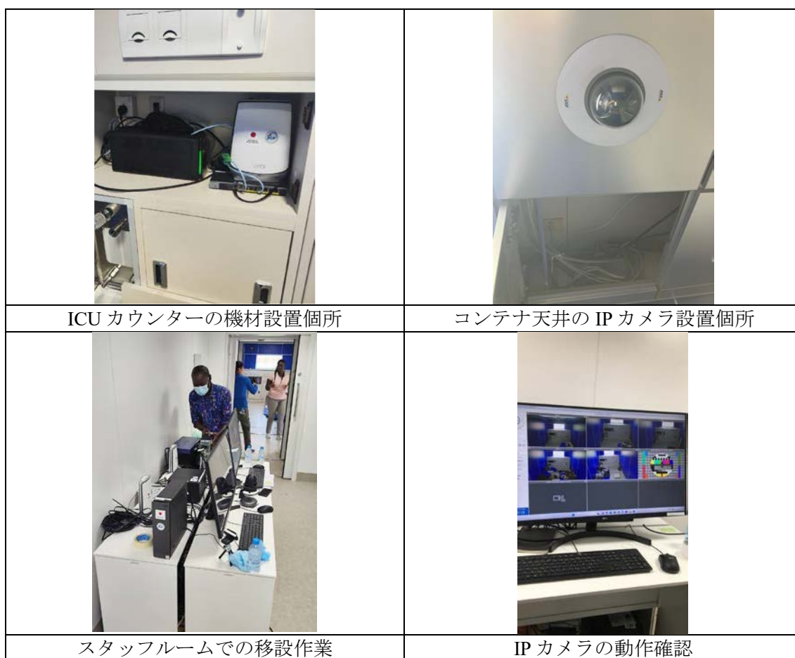
図 3-50 コンテナ ICU へ遠隔 ICU 通信システム移設時の様子
