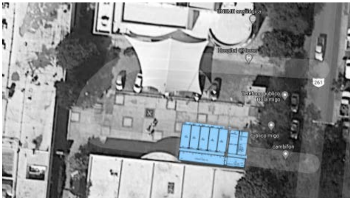
図 3-88 コンテナ ICU の設置場所（メキシコ・オーラン総合病院）
