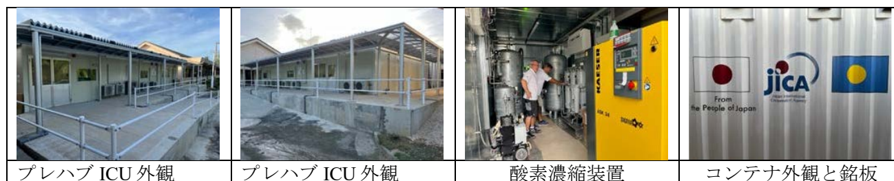
図 3-28 プレハブ ICU の完工検査（パラオ）
