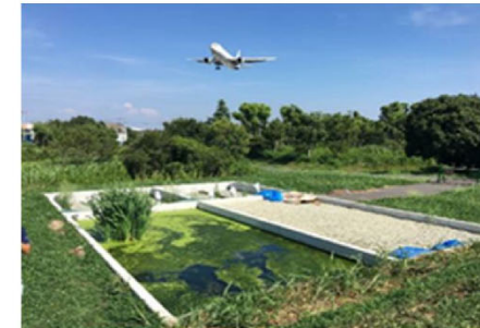
干満式人工湿地による自然浄化システム
