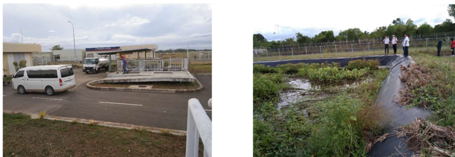
写真 3-2 パングラオ国際空港の下水処理場(調査団撮影)
