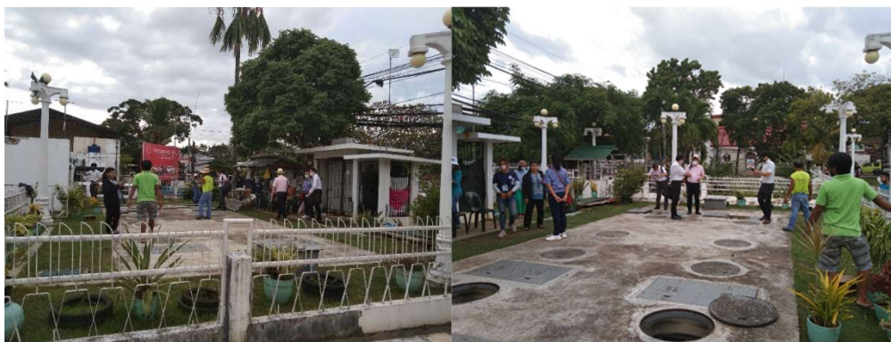
写真 3-1 ボホール州設置の浄化槽の様子(調査団撮影)
