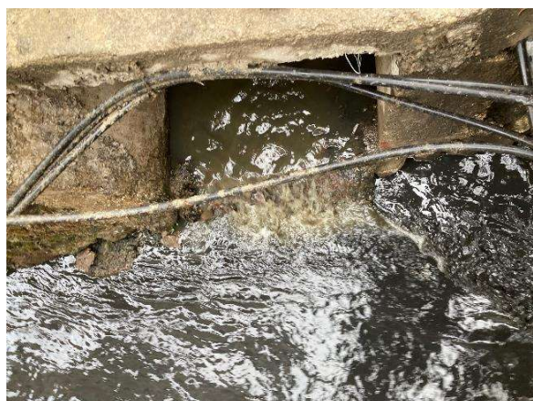
写真 2-2 Communal plant から排出される処理水 (提案法人撮影)
