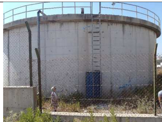
[写真-6] 場内配管設備の更新対象の既存配水池（Al Jabreyat）
