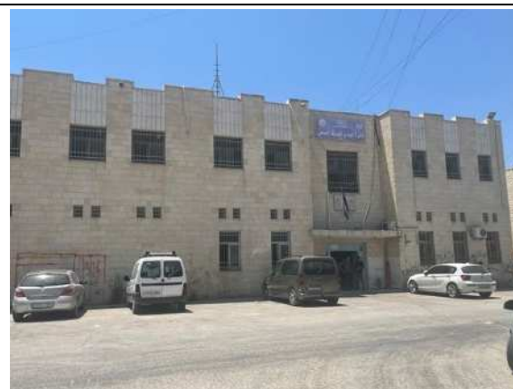
[写真-2] ジェニン市上下水道部庁舎（本事業で SCADA 中央監視室を設置する）
