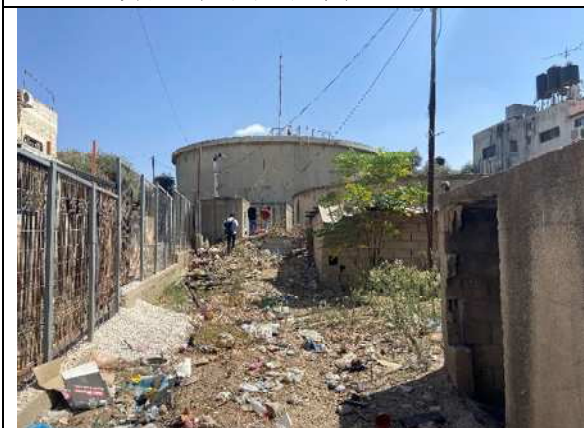
[写真-5] 場内配管設備の更新対象の既存配水池（Al Marah）
