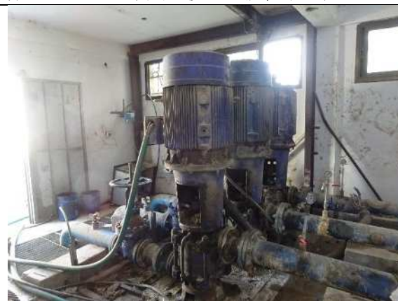
[写真-4] 設備の更新対象の既存送水ポンプ場（Al Saadeh）
