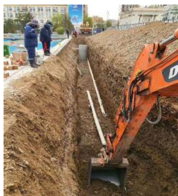
Нийслэлийн хөрөнгөөр Сүхбаатарын талбайн урд талын “Хонхтой цэцэрлэг, Сити Тойлет”-н цэвэр болон бохир усны шугамын угсралтын ажлыг хийж гүйцэтгэсэн. Цэвэр усны Ф-50мм шугам 300м, Бохир усны ф-150мм шугам өөрийн урсгалтай 200м, даралттай 100м шугамыг тус тус угсарч байнгын ашиглалтан оруулсан.
