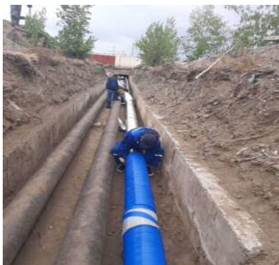
Автобус 2-н салаа цэвэр усны ф200мм шугамыг 190м газарт шинэчлэн сольсон.
