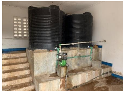
写真 3.4.19 ナカトンゴレ浄水場（ろ過池（左）、薬注ポンプ(中央)、天日乾燥床（右））
