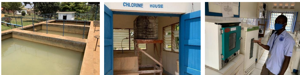
写真 3.4.10 ホイマ浄水場（急速ろ過池（左）、塩素室（中央）、水質検査室（右））
