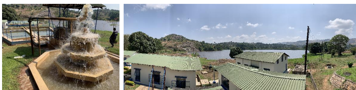
写真 3.4.14 カトマ浄水場（エアレーター（左）、浄水場からカトマダムを望む（右））
