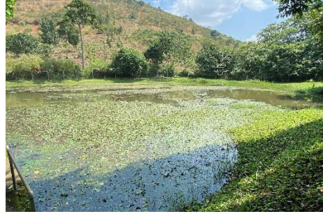
カチワマンゴ湧水堰
