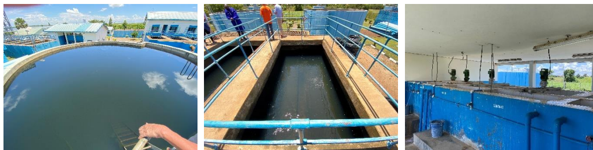
写真 3.4.27 アウージャ浄水場（沈殿池（左）、急速ろ過池（中央）、薬注施設（右））
