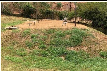
カセニィ地下貯水池
