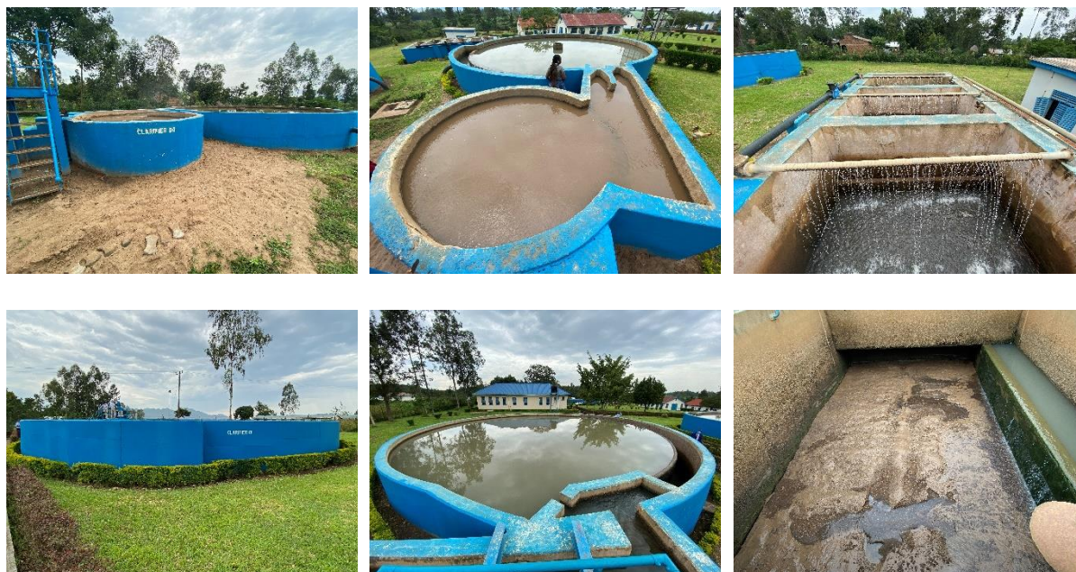
写真 3.4.23 マラバ浄水場（1956年建設）（沈殿池（左上）、沈殿池（中央上）、急速ろ過池（右上））、マラバ浄水場（1986年建設）（沈殿池（左下）、沈殿池（中央下）、急速ろ過池（右下））
