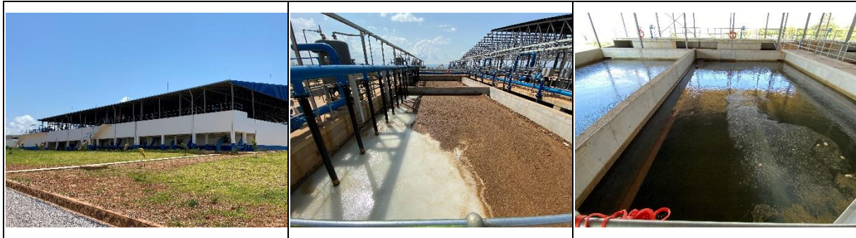
写真 3.4.3 カトシ浄水場：浄水場全景（左）、加圧浮上分離池（中央）、急速ろ過池（右）
