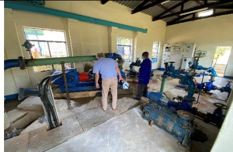
カトマポンプ場
