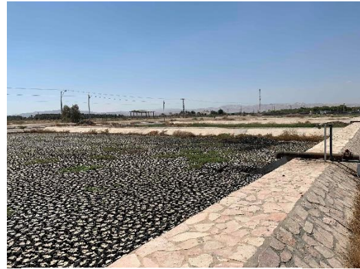
الصورة 2.1.1 حوض تجفيف الحمأة
