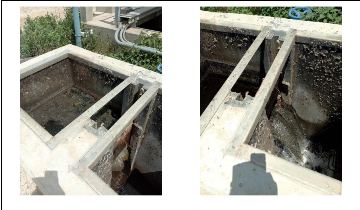
صورة 2.2.6 غرفة تحويل مجرى المياه
