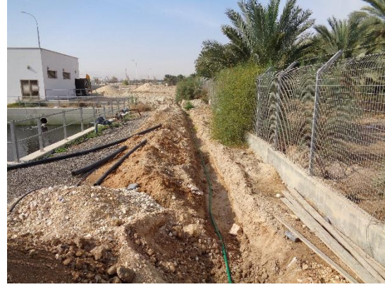
الصورة 2.1.7 تنفيذ خطوط كهرباء جديدة
