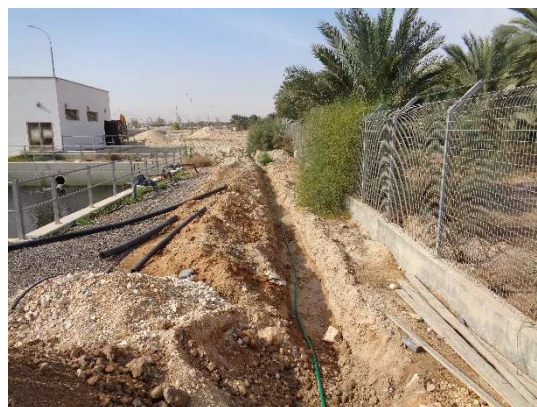
写真 2.1.8 動力ケーブル増設工事
