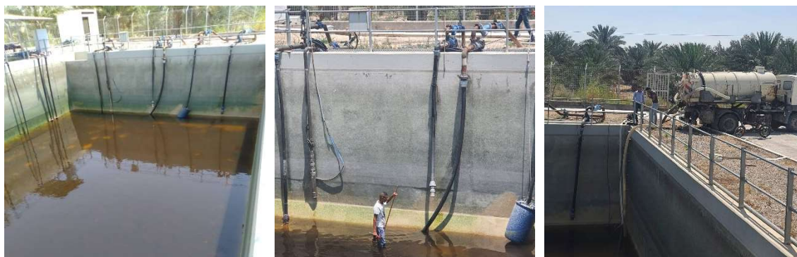
写真 2.1.9 灌漑用水タンクの清掃
