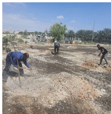
写真 2.3.14 プランテーション整地中 (2)
