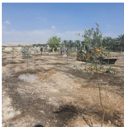
写真 2.3.13 プランテーション整地中 (1)
