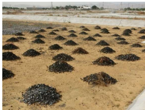
写真 1.1 乾燥汚泥床の乾燥汚泥
