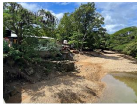
1. 橋梁付近下流側
