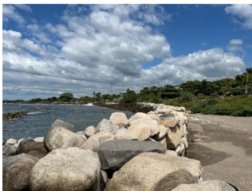
2018 年に新設した Dike
