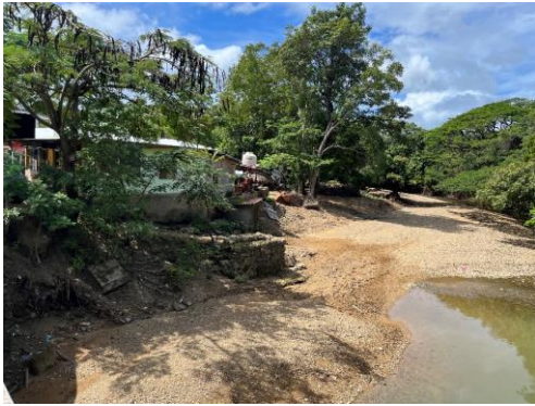
橋梁付近下流側
