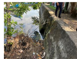
10. 護岸の排水 (バルブ有)
