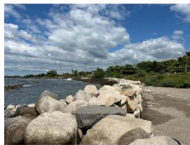
2. 2018年に新設したDike
