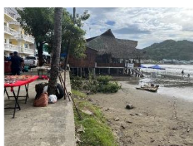
11. 護岸整備状況
