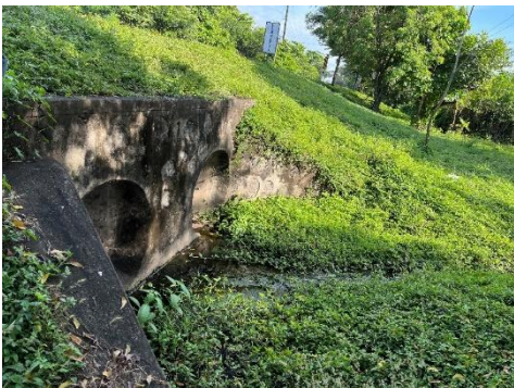
道路沿いの排水路
