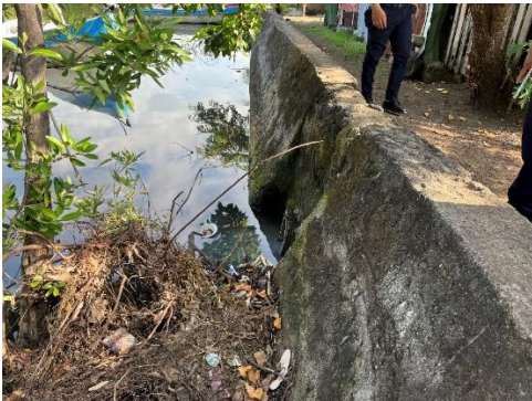
護岸の排水（バルブ有）
