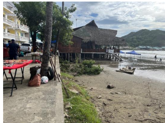
護岸整備状況
