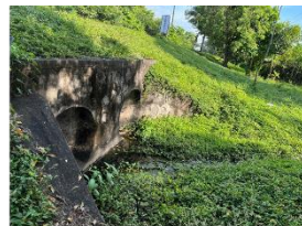
11. 道路沿いの排水路
