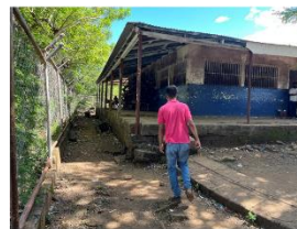
5. 学校（基礎部高上げ）
