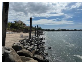
1. 突堤基部 (Dike開始部)
