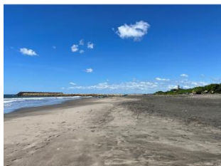
2. 砂浜海岸（港建設中）
