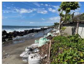
4. Dikeで侵食防護
