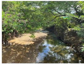
2. 橋梁付近上流側
