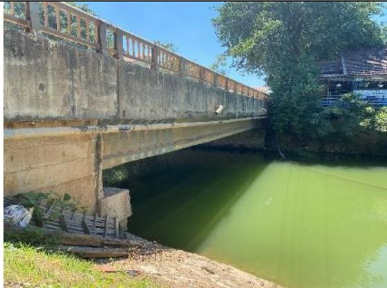
橋長は 31m だが、橋桁部分は 21m のみ
